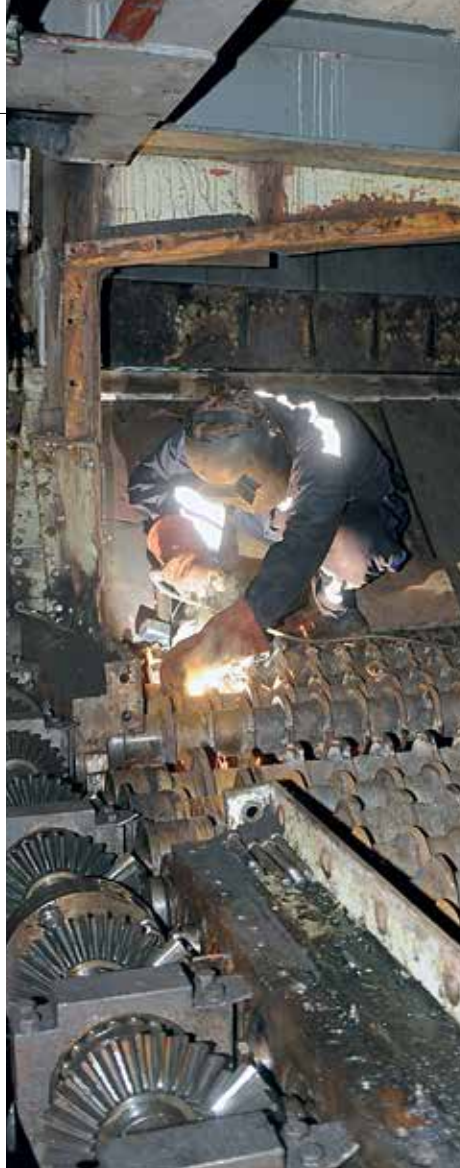
■ Наваривање ролен-рост решета
