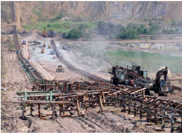
■ Реконструкција у току
