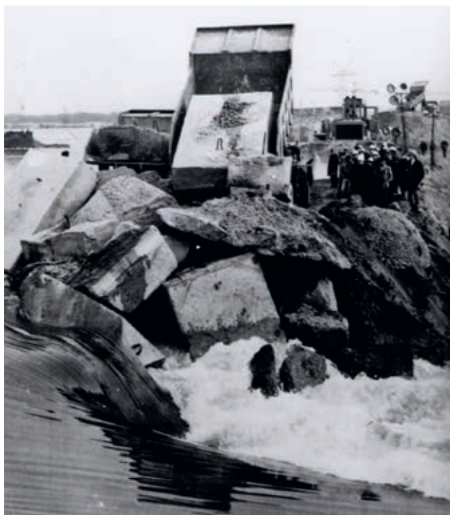
■ Габиони, бетонске коцке од по 10 тона испунили су дно реке
