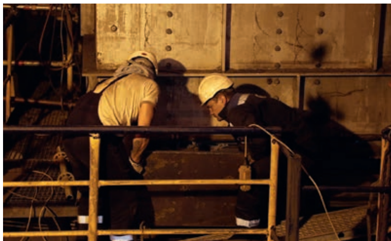
■ Замена металних плоча млиновима блока А6
