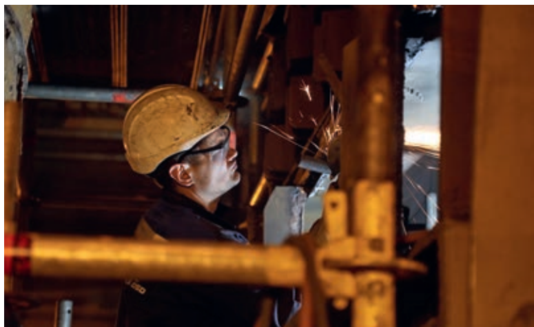
■ Брушење отвора на сихтеру блока А6
