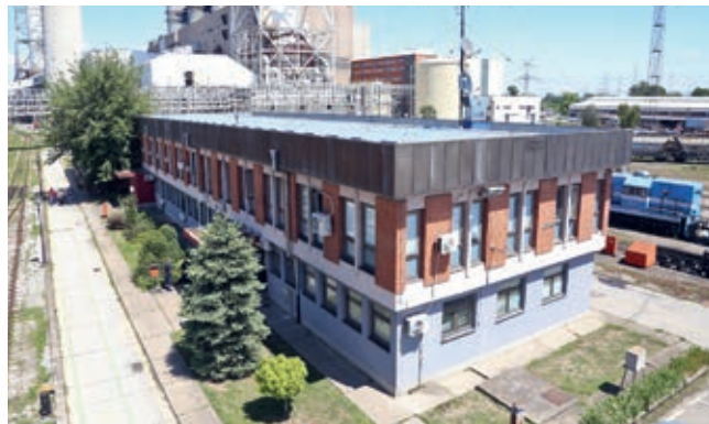
■ ЦДУ ЖТ ТЕНТ имаће 104 фотонапонска панела
