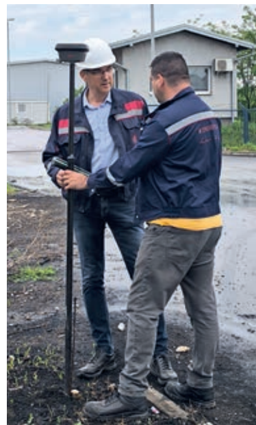
■ Провера трасе каблова
