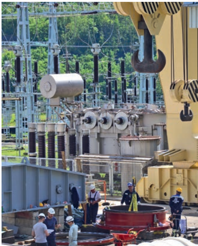
Демонтажа прстена кугластог затварача
