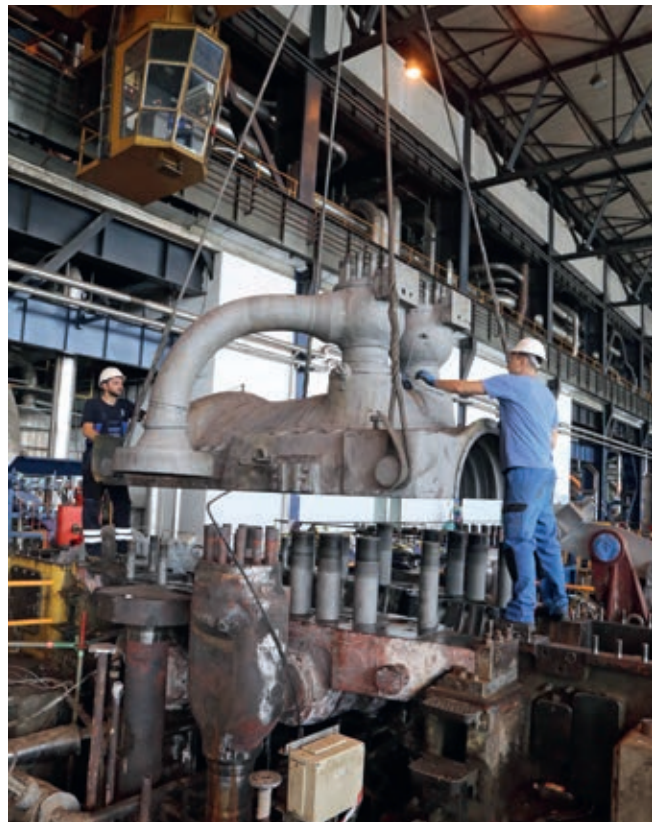
■ Подизање поклопца турбине високог притиска
