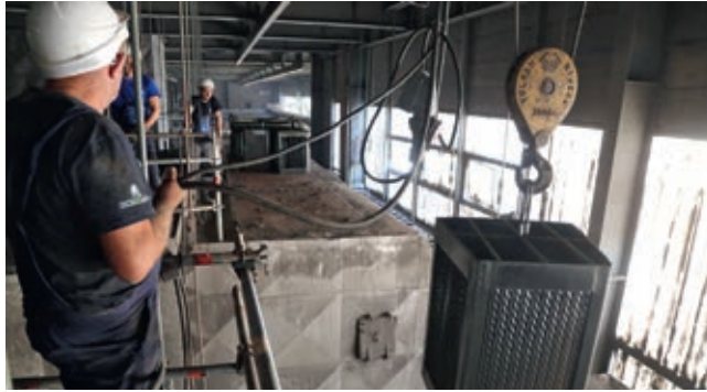
■ Извлачење саћа из ротационог загрејача ваздуха (ЛУВО)
