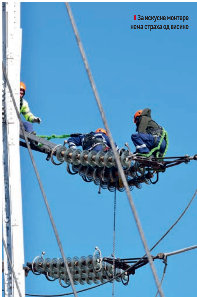
■ Само један чланак изолятора може донети прекид у преносу електричне енергије
