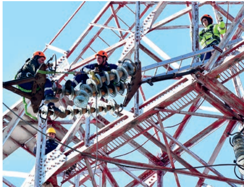
■ Само један чланак изолятора може донети прекид у преносу електричне енергије
