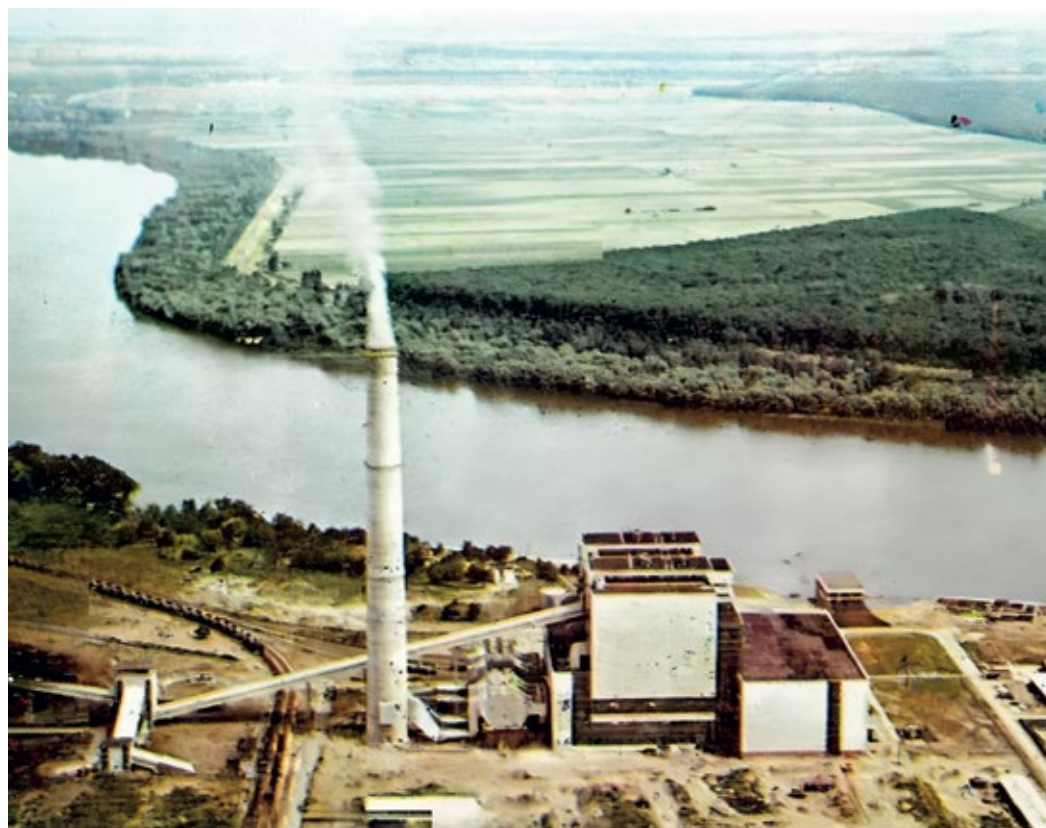
■ Термоелектрана „Обреновац“ из времена изградње блокова 3 и 4
