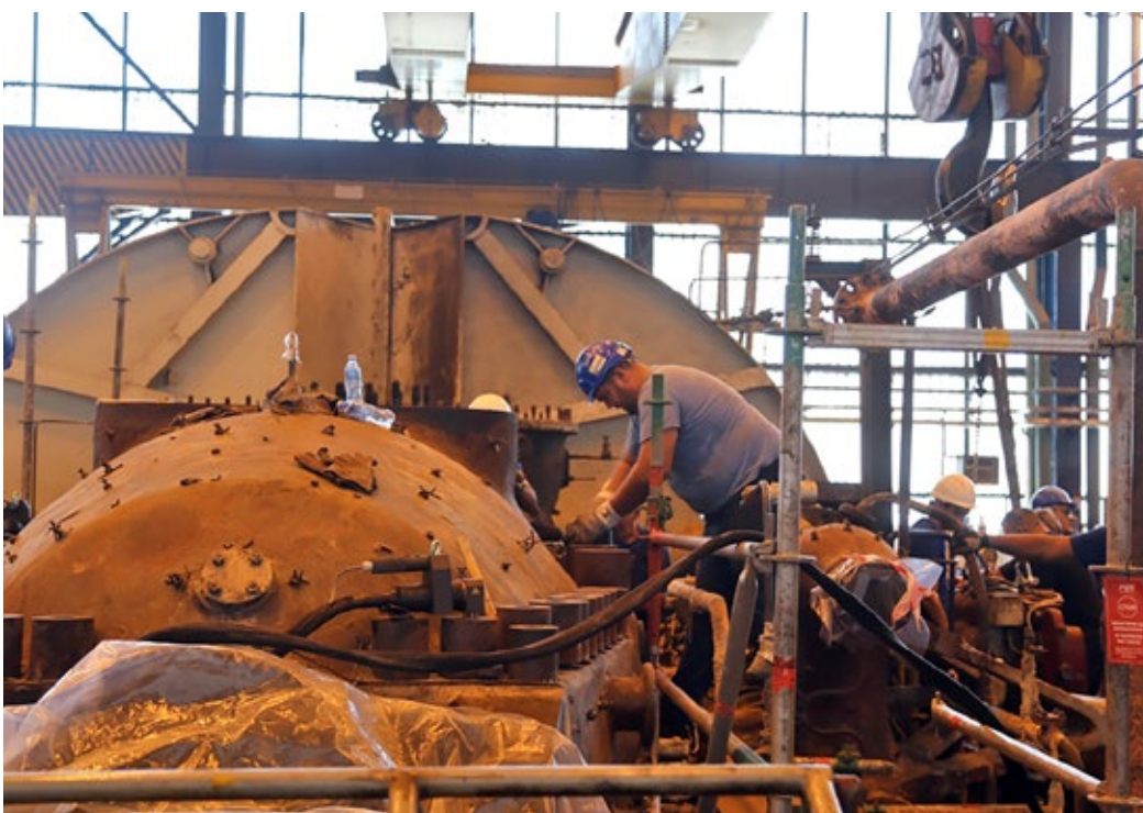
■ Припремни радови за ремонт турбо блока ТЕНТ А5
