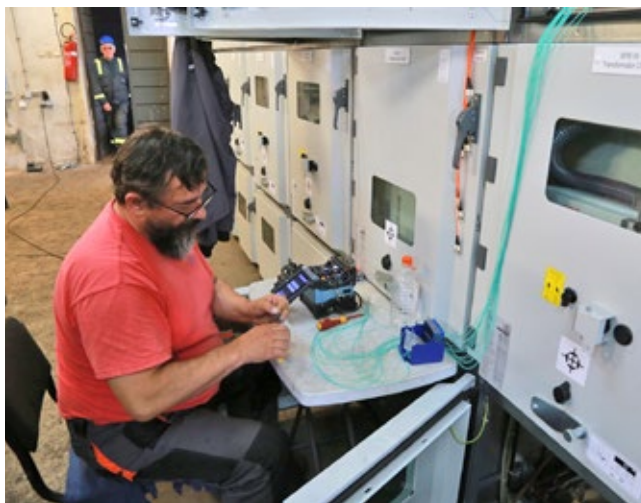
■ Повезивање оптичких каблова
