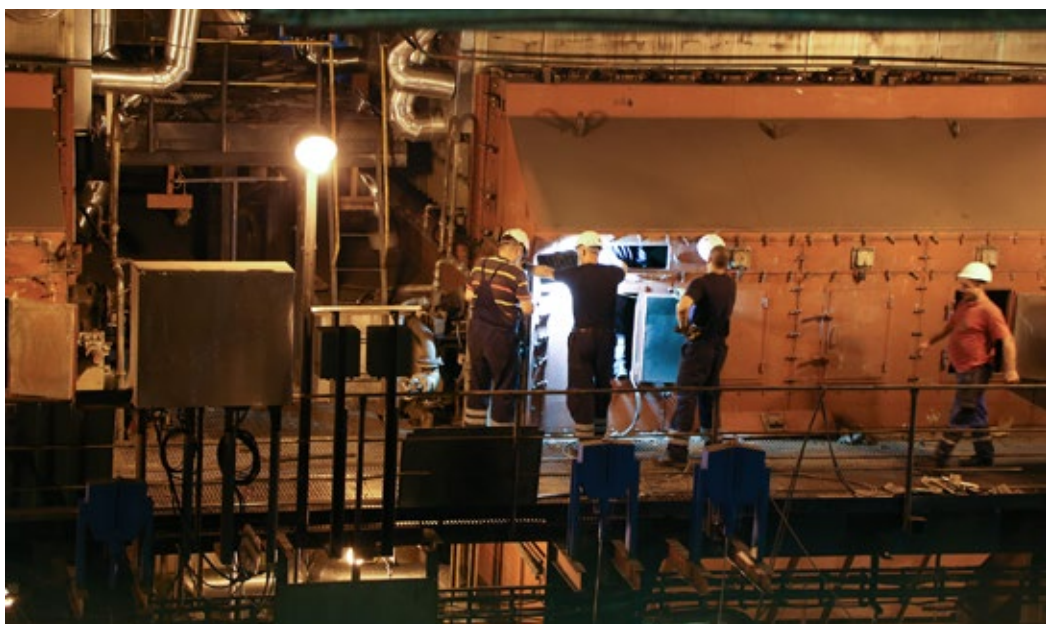
■ Завршни радови на котловском постројењу
