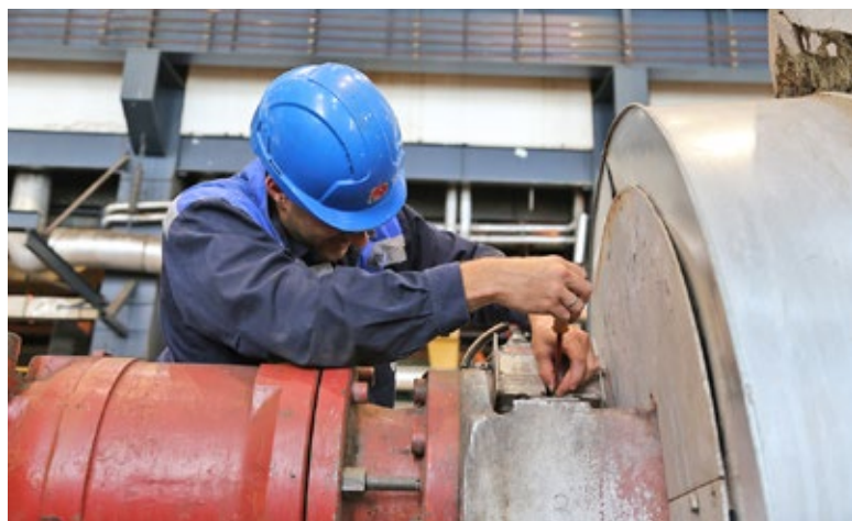
■ Провера вентила на турбини високог притиска
