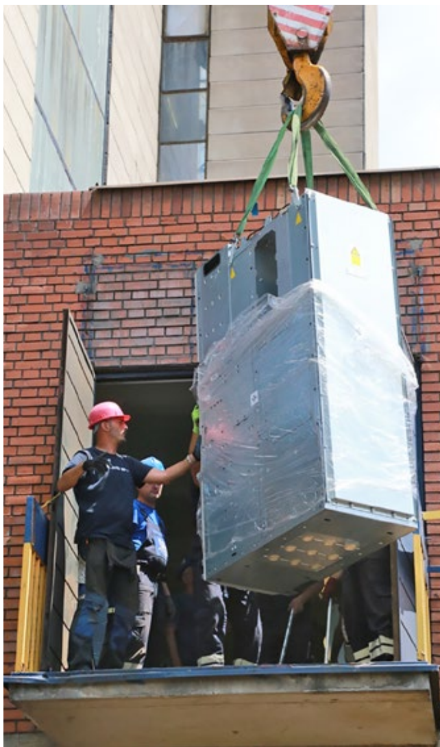
■ Пријем и убацивање 6 kV хелије на висини 4,5 метара
