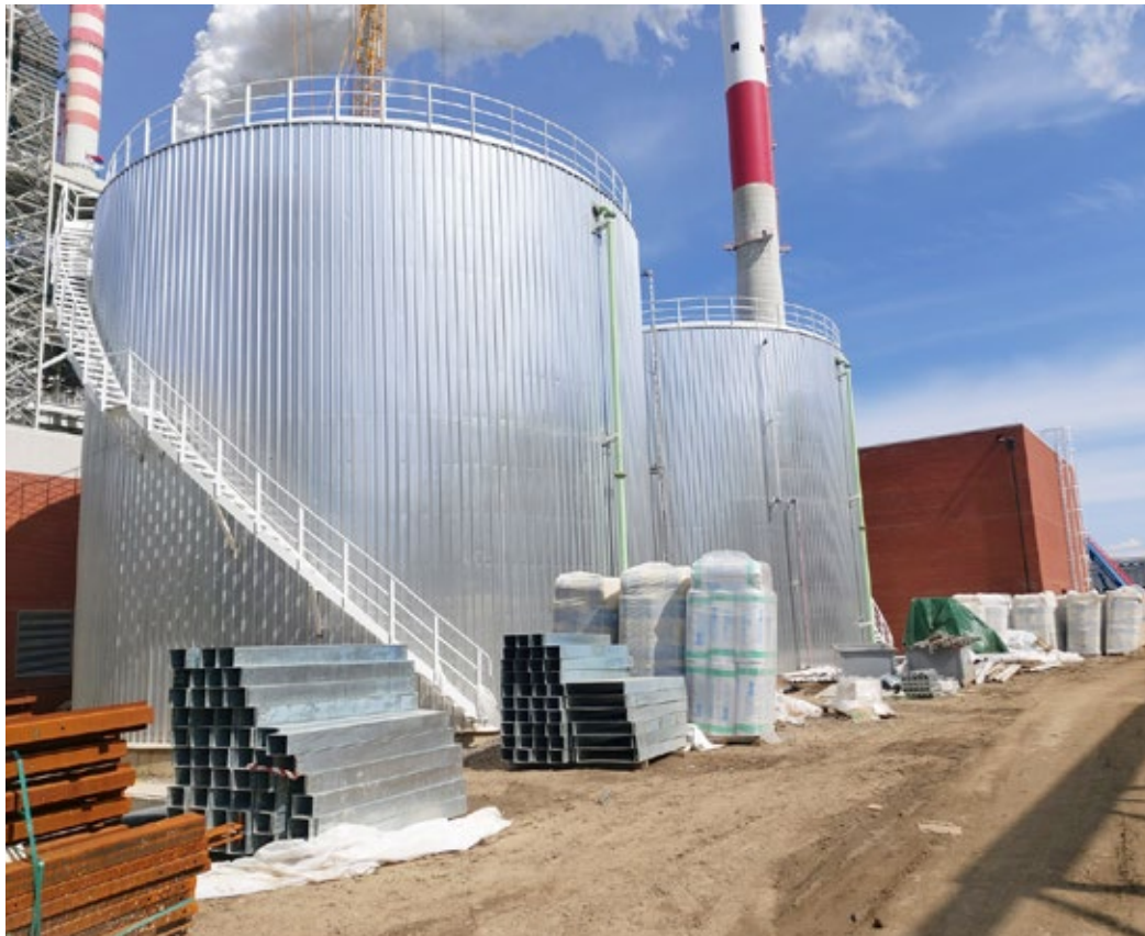
Радови на резервоарима
