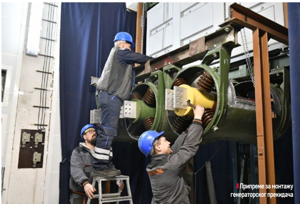
Радови на шинским везама генератор – блок-трансформатор
