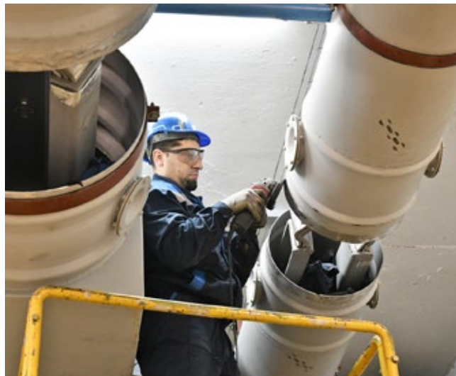
Радови на шинским везама генератор – блок-трансформатор
