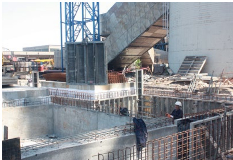
■ Постављање оплате за бетонске радове
