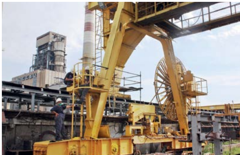
■ Ремонтни послови на претоварном мосту 1
