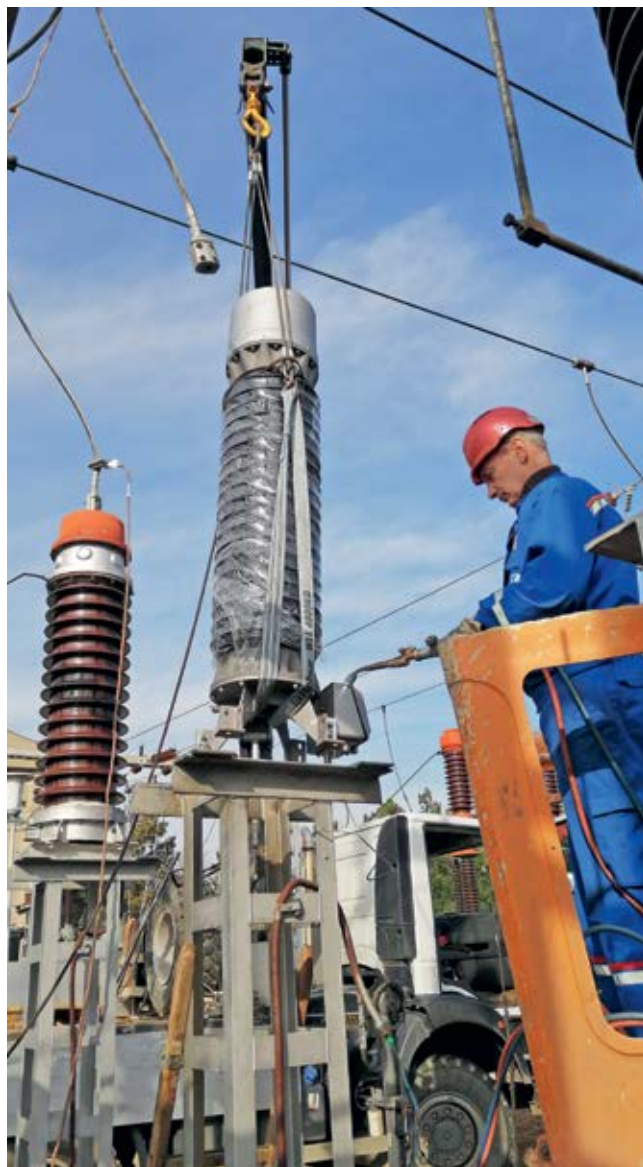
■ Замена мерног трансформатора 110 kV на ТС „Стара Пазова“
