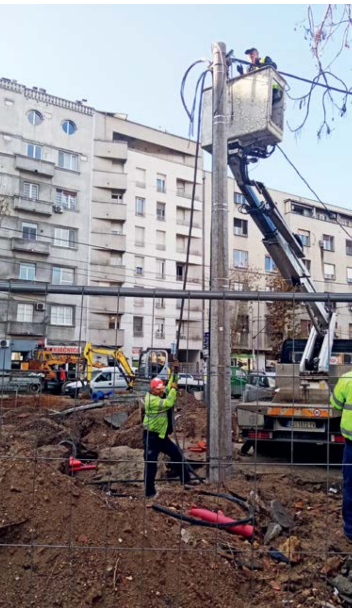
■ Надземна мрежа је спуштена и калибрирана у подземну
