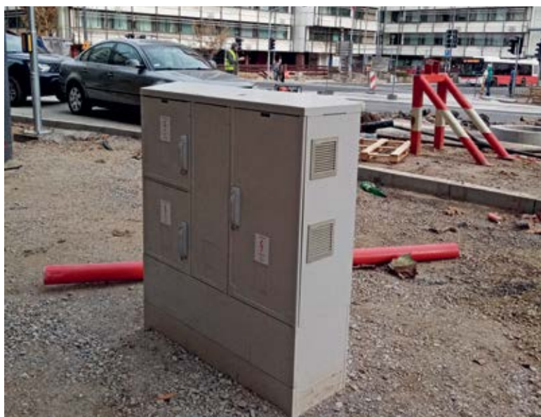
■ Постављени су савремени разводни ормани са измештеним местом мерења
