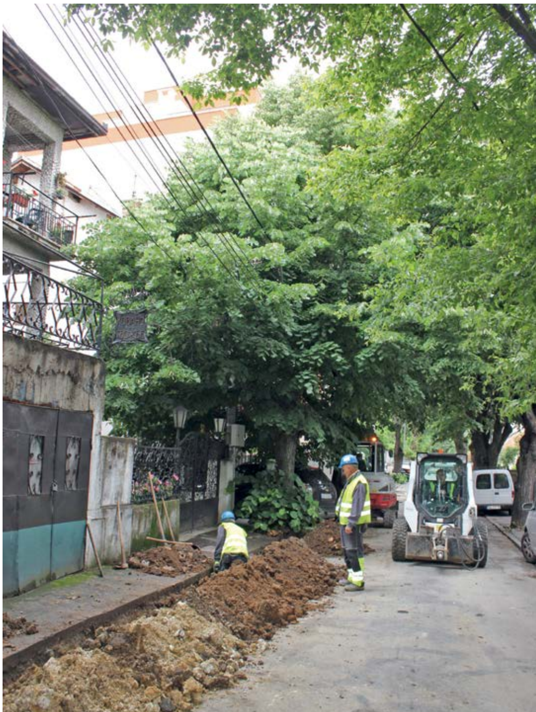
Радови на полагању нове кабловске мреже за напајање стамбеног објекта
