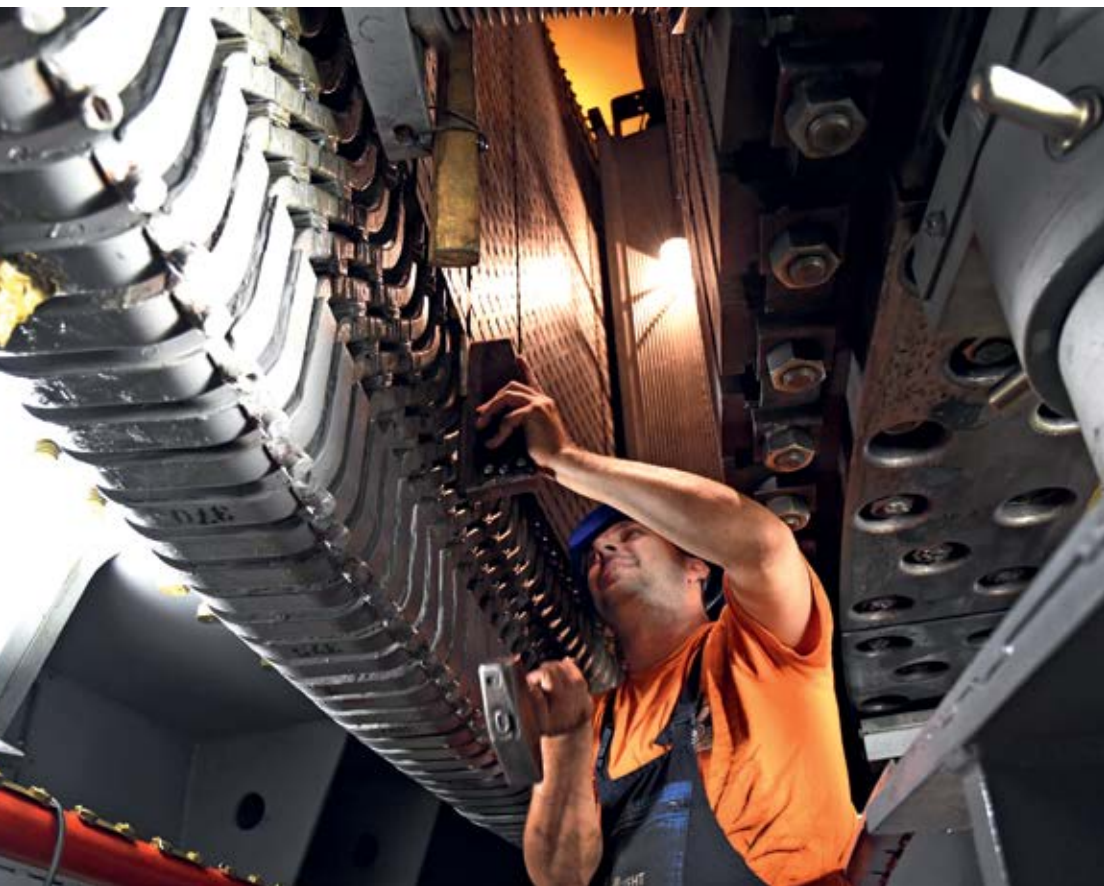
■ Генератор А 2, неопходно је преклињавање 13 жлебова: Дарко Лазаревић
