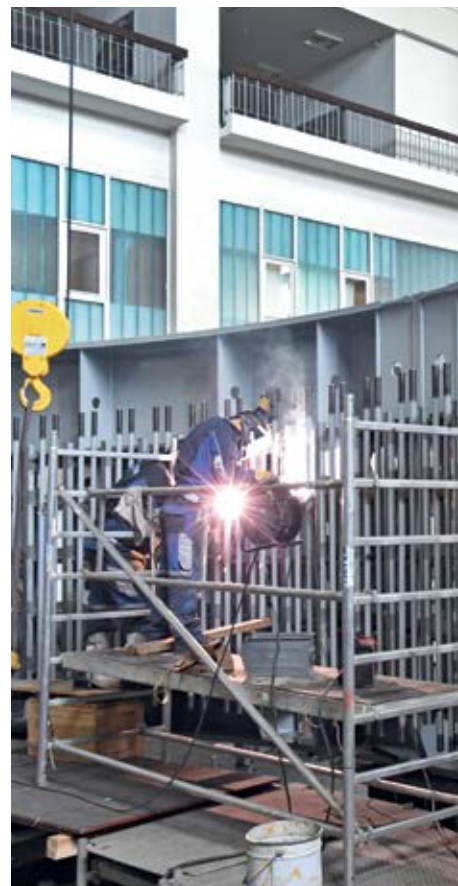
■ Нови статор главног генератора А 3. Заваривање
