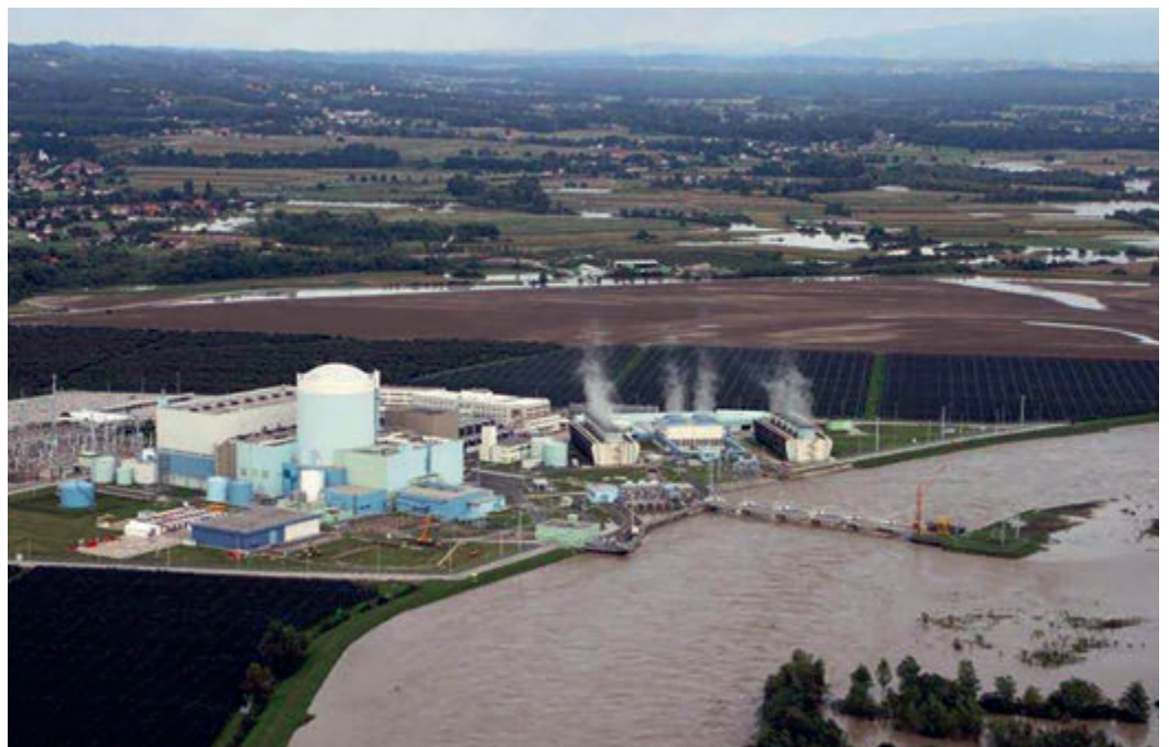
■ Нуклеарна електрана „Кршко“
