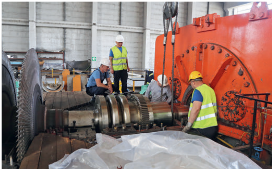
■ Стандардни ремонт блока у пуном замаху
