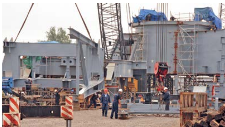
■ Монтажа доњег строја багера SRS 2000
