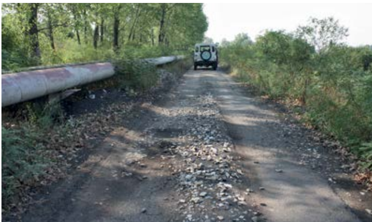
|| Оштећене деонице приступног пута су представљале опасност по исправност возила
