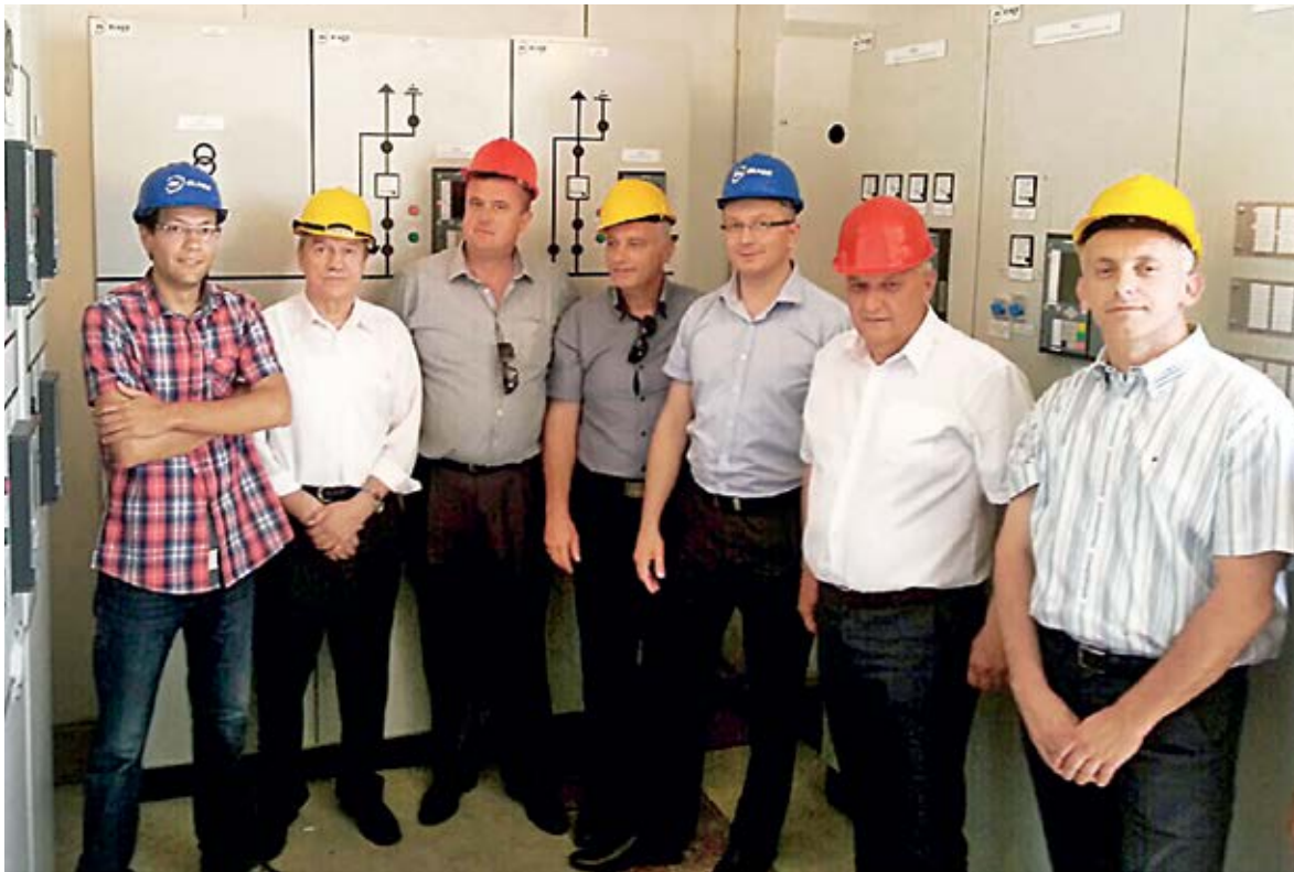
■ Део тима који је радио на реконструкцији ТС
