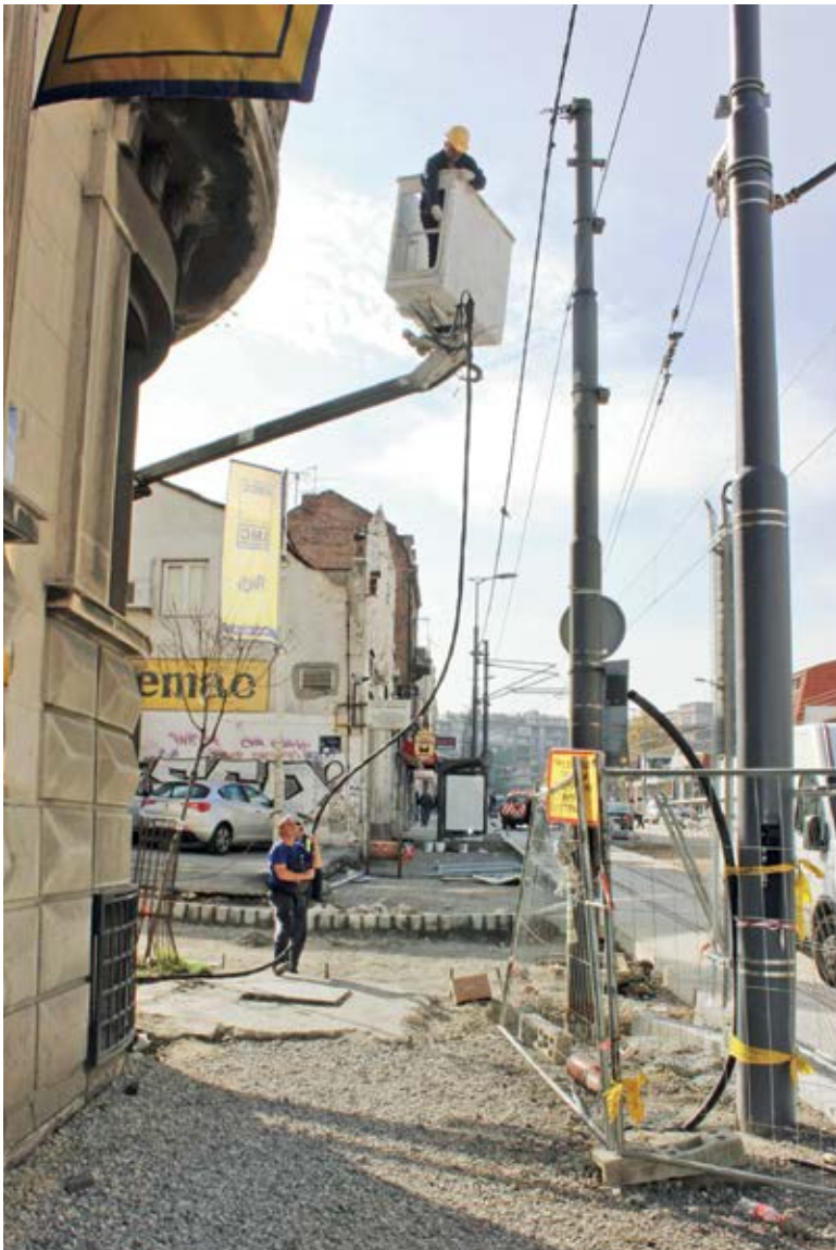
Демонтажа надземне мреже
