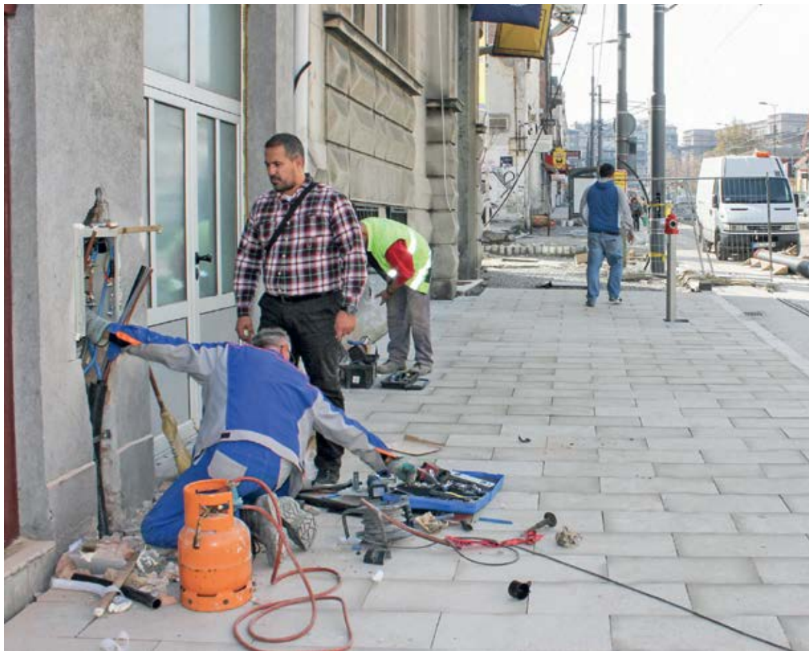
■ Монтажа новог кабловског прикључка и кабловске кутије
