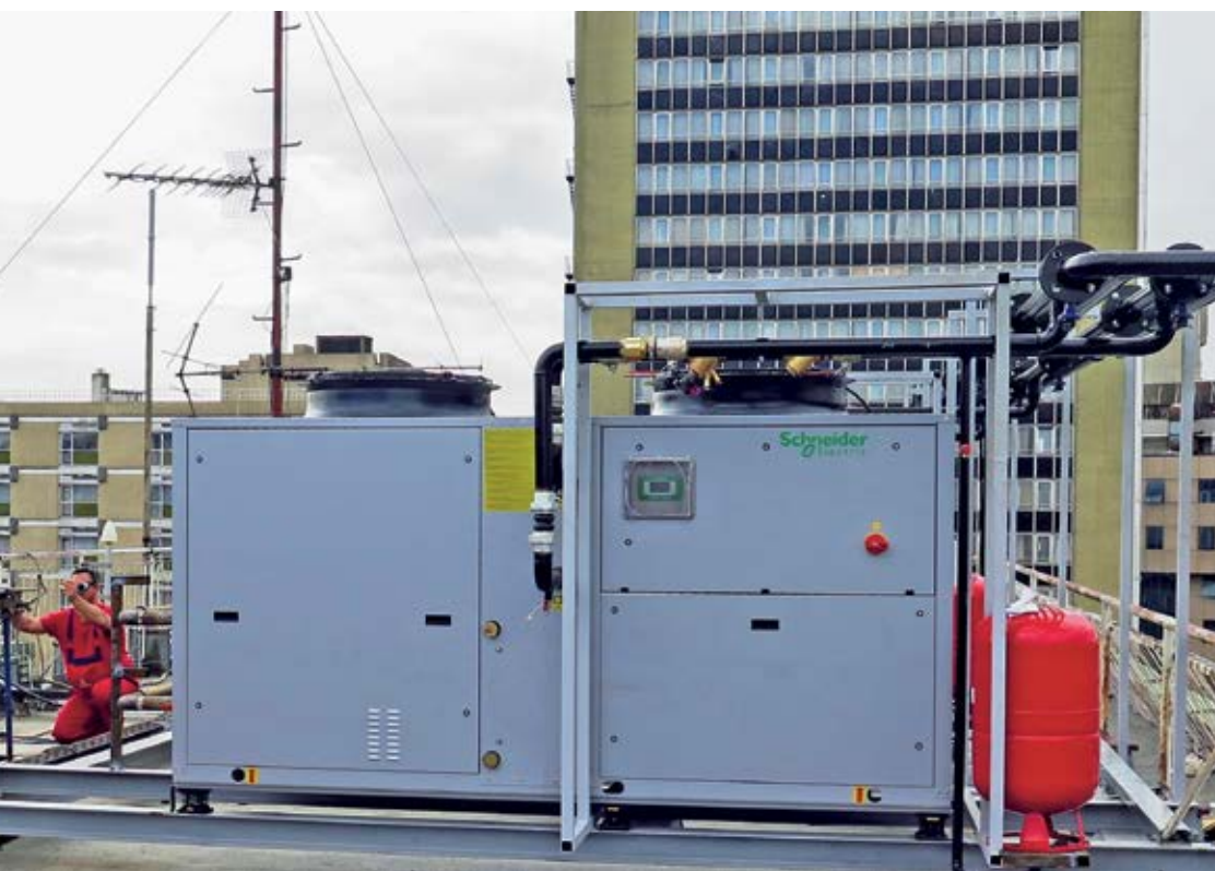
Постављање чилера – савременог расхладног система за сервер салу пословног објекта Славија
