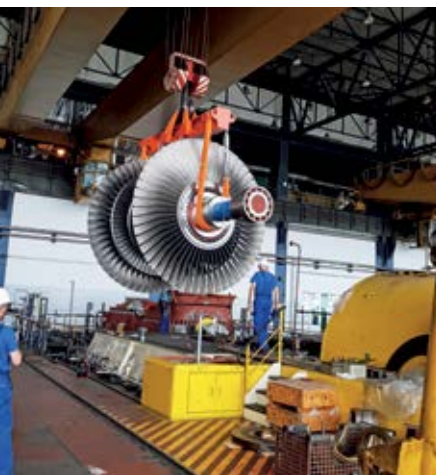
■ Са ремонта „четворке“
