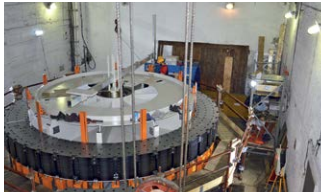
■ Ротор генератора
