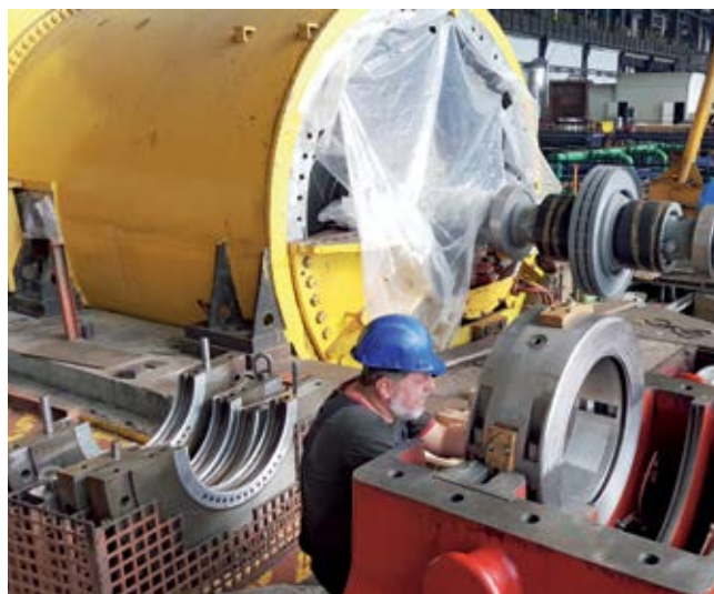
■ Радови на будилици блока ТЕНТ А4
