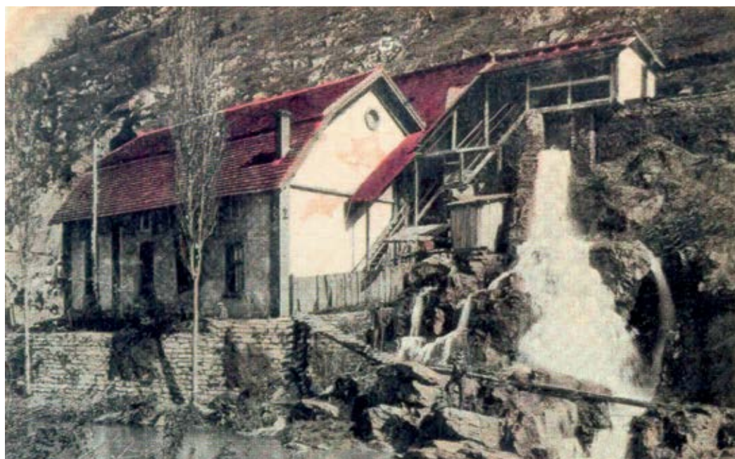
■ Хидроелектрана „Под градом“ код Ужица
