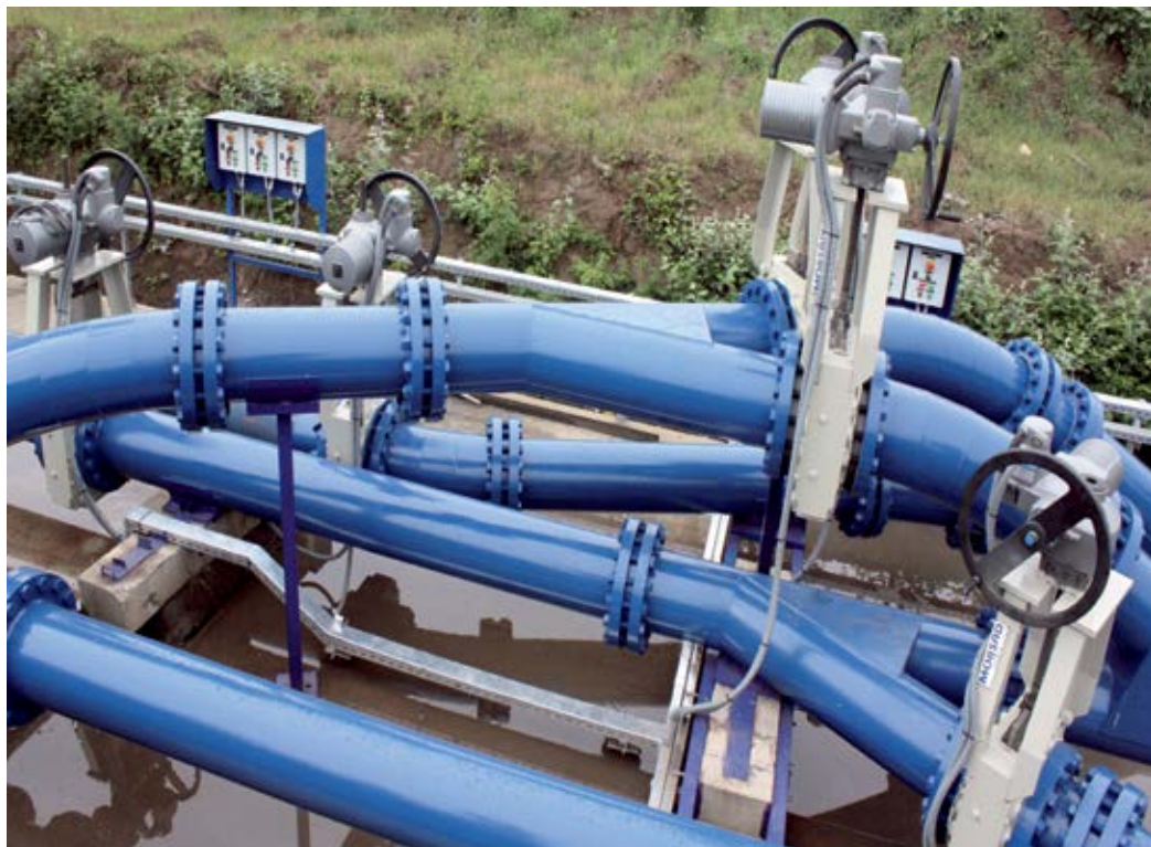
■ Помоћу вентила брзом манипулацијом може да се чистом водом испере загушени цевовод
