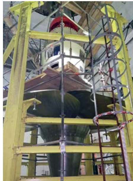
■ Компактна монтажа турбине агрегата А3 у монтажnoj сали
