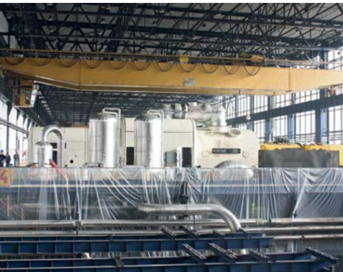
■ Почетак демонтажних радова на блоку ТЕНТ А4
