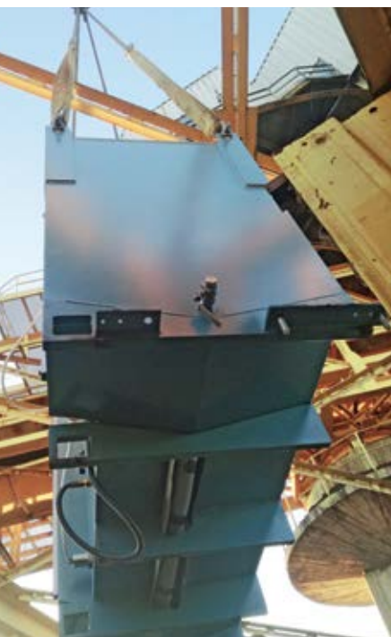
■ Монтажа новог хидрауличног агрегата
