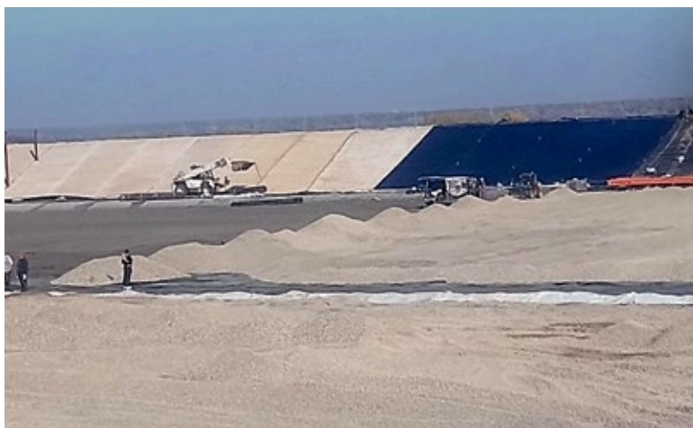
■ Касета 1 - монтажа фолије
