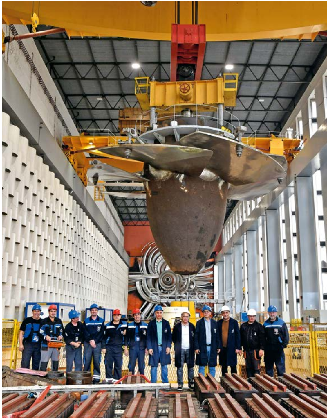
■ Група великих професионалаца – демонтажа радног кола Капланове турбине после 51 године рада
