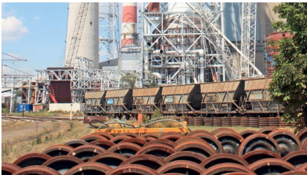
■ ЖТ укључен у пројекат изградње постројења ОДГ
