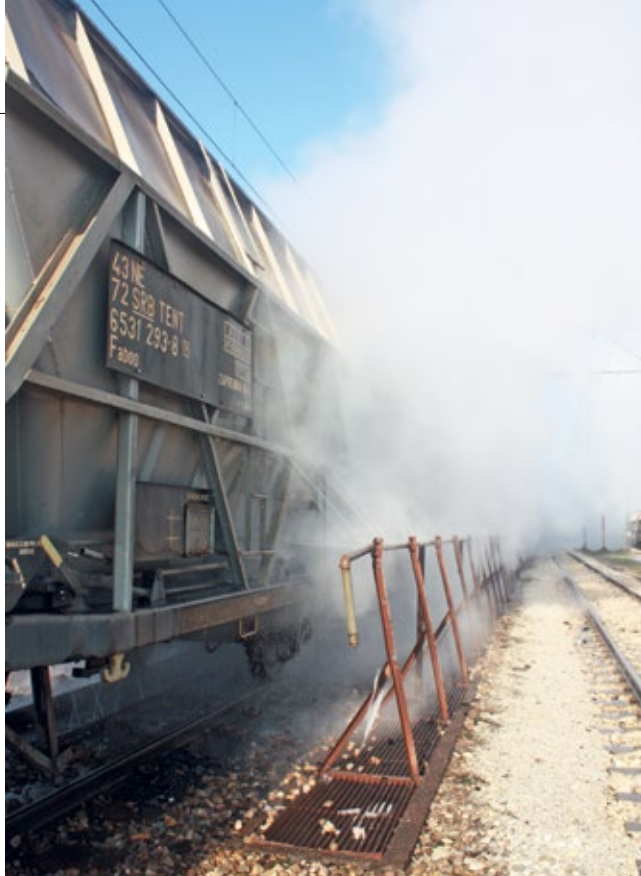
■ Постојење за одмрзавање у ТЕНТ А
