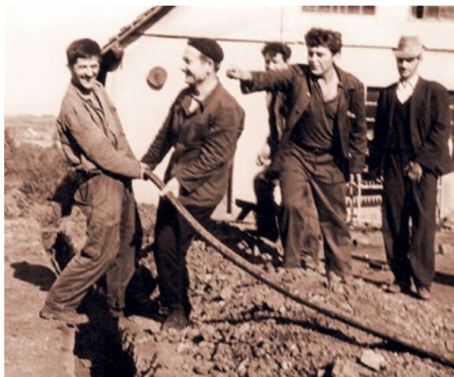
■ Постављање електрокабла у „Јунковцу“
