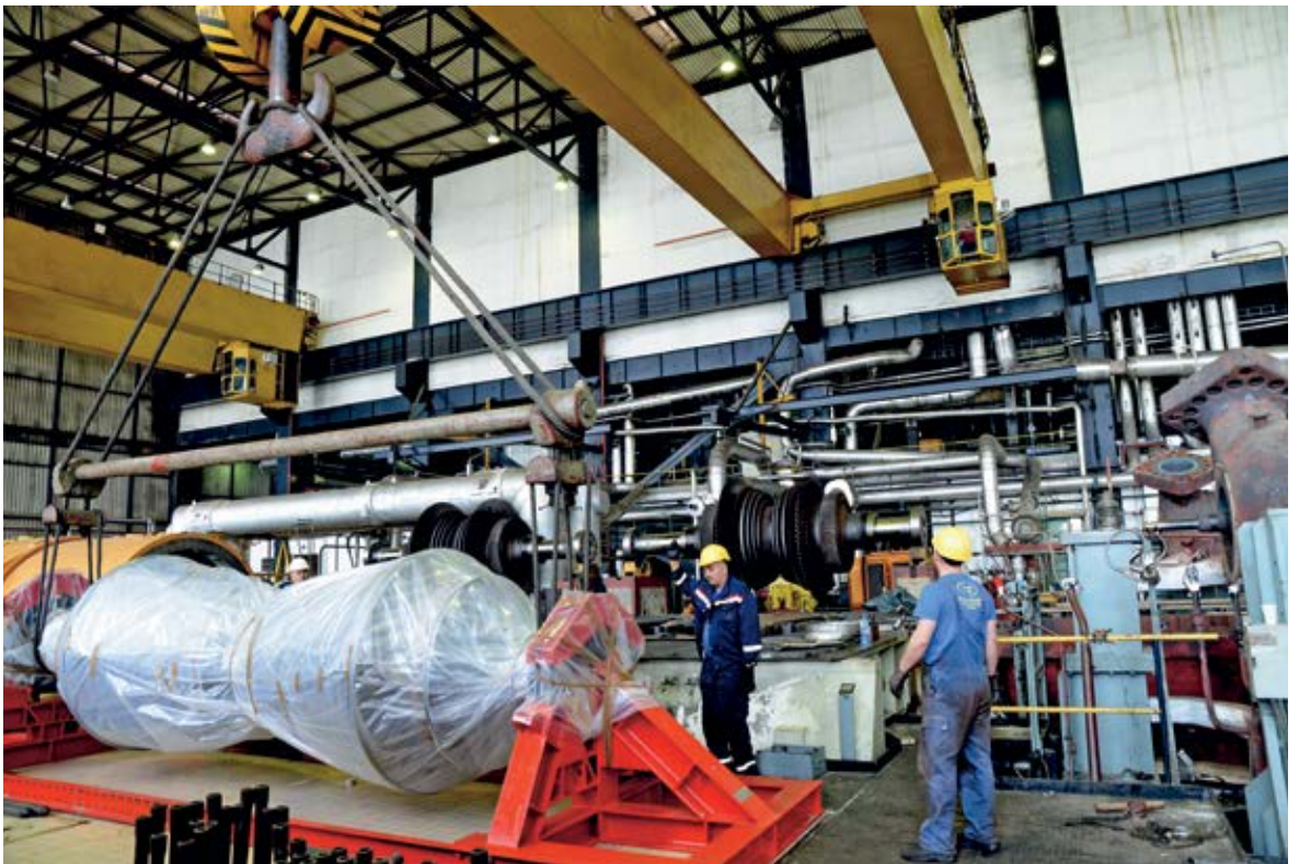
Дизање ротора турбине високог притиска током овогодишњег ремонта ТЕНТ Б2
