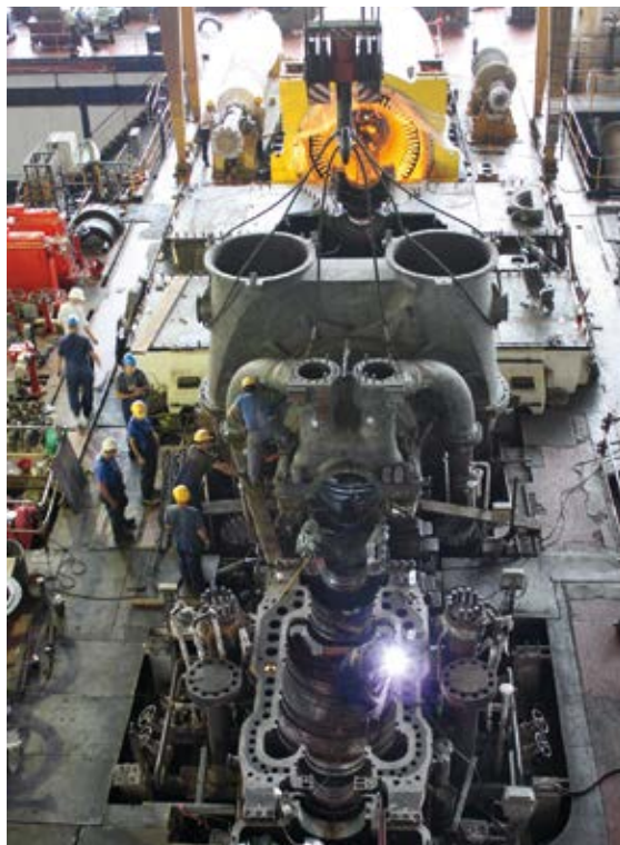
■ Поглед на демонтиран турбогенератор
