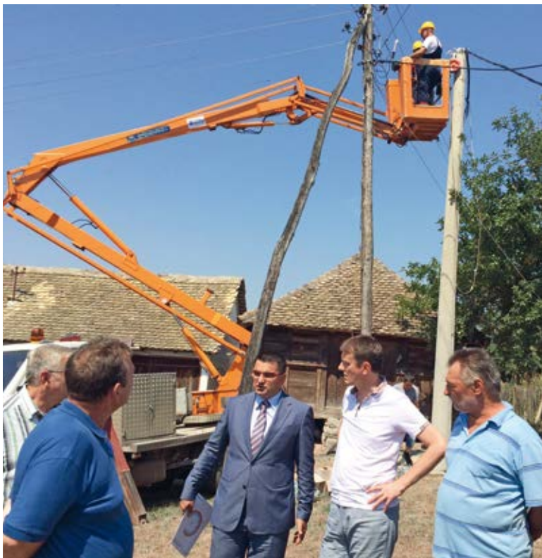
■ Акција замене дрвених стубова бетонским
