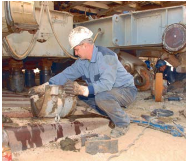
■ Ремонтна сезона трајаће од априла до краја октобра
