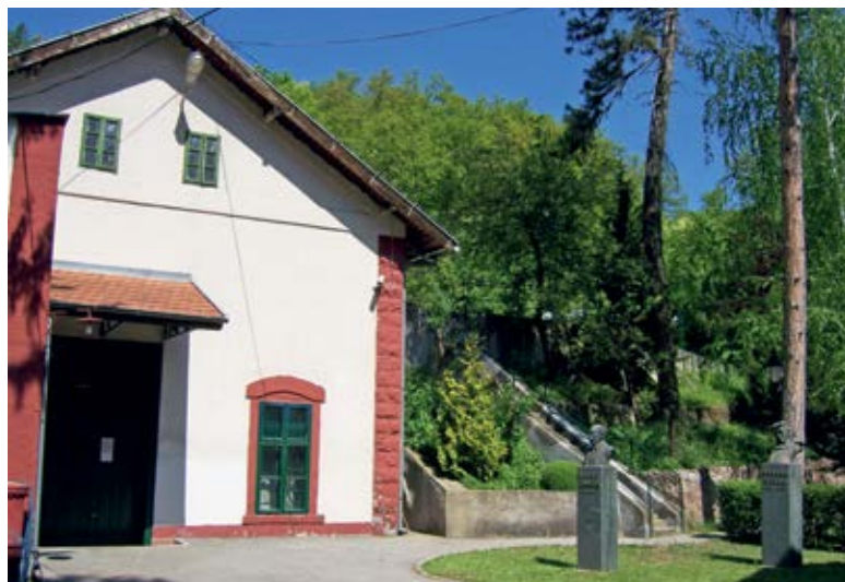
■ Зграда електране и бисте Николе Тесле и Ђорђа Станојевића
