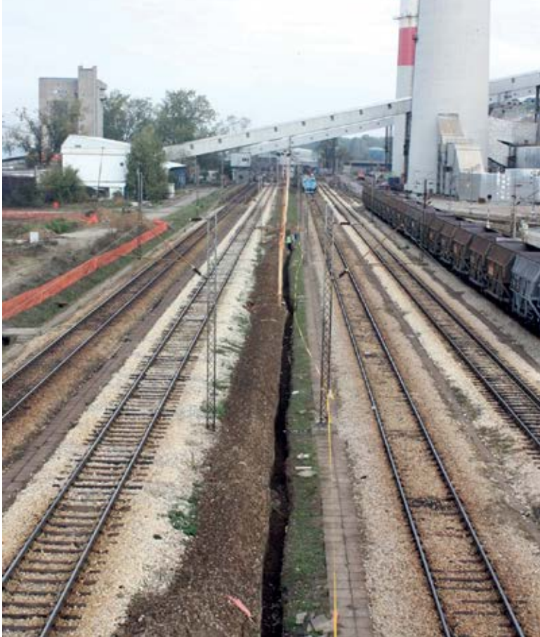
■ Измештање сигналних каблова између колосека 2 и 3
