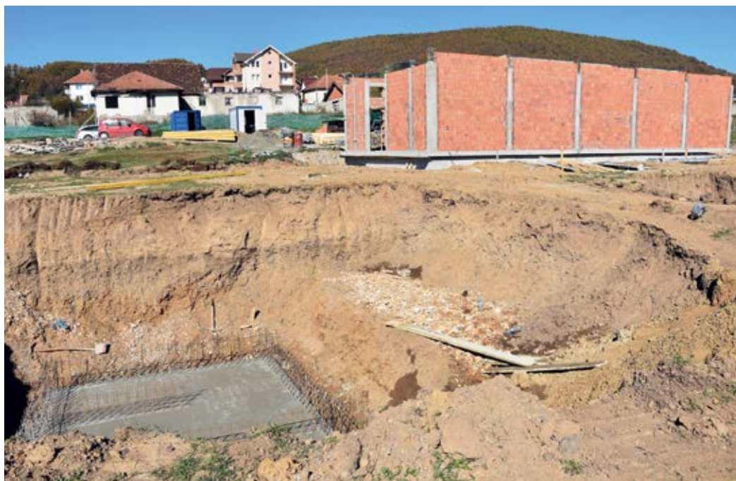
Почетак изградње ТС „Тутин“
