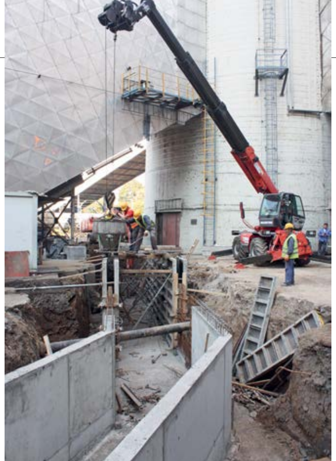
■ Изградња бетонског канала за нову трасу пепеловода
