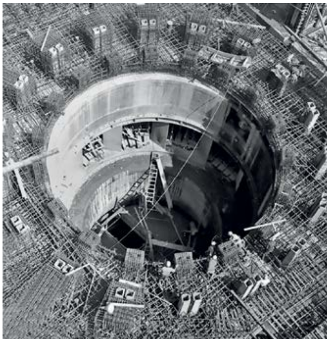
■ Турбинска јама, припрема за бетонирање, фото: Драгиша Радуловић
