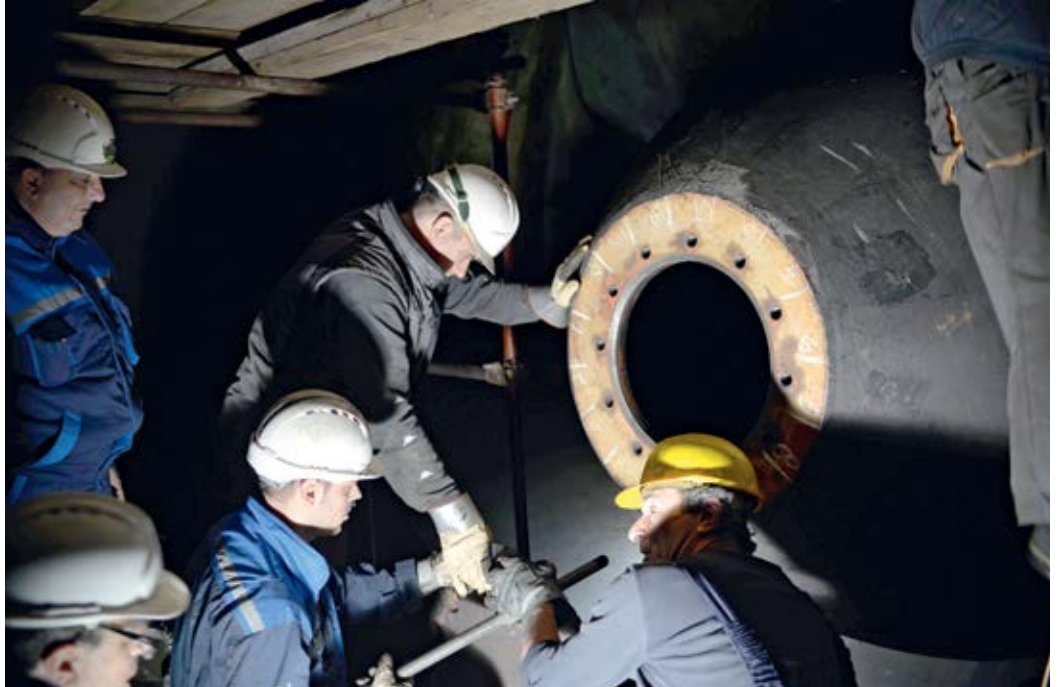
■ Затварање поклопца главчине радног кола
