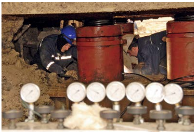
■ Ремонти на ПК „Дрмно“
