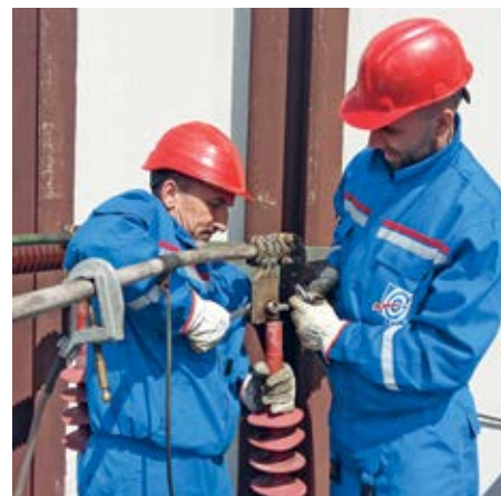
■ Ремонтни радови у ТС 35/10 kV „Сопот“
