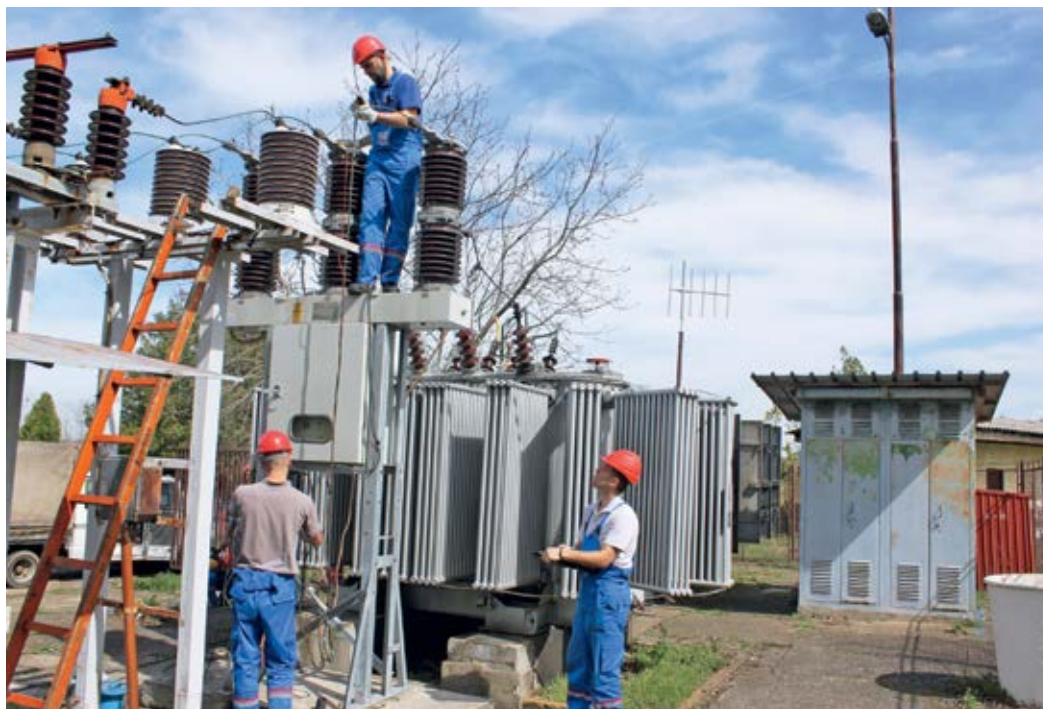
■ Трафостаница 35/10 kV „Железник 2“ – превентивно одржавање
