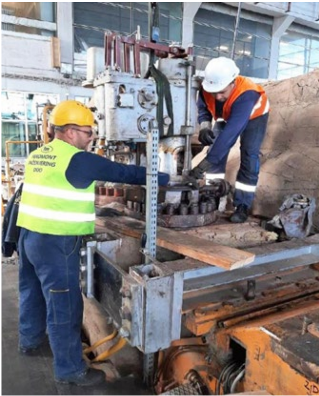
■ Ремонт БЗВ вентила турбине средњег притиска
