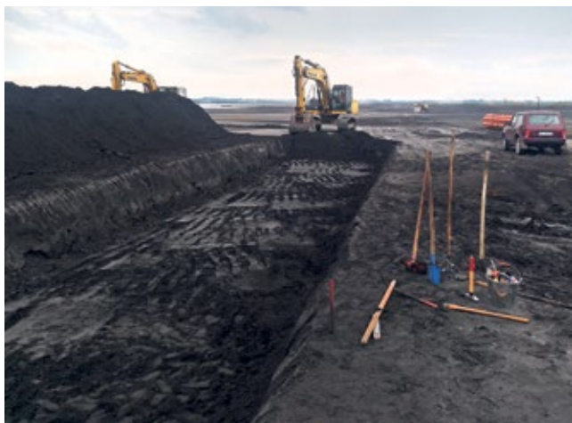
■ Копање канала за трећи дренажни прстен
