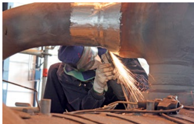
■ Радови под пуном заштитном опремом
