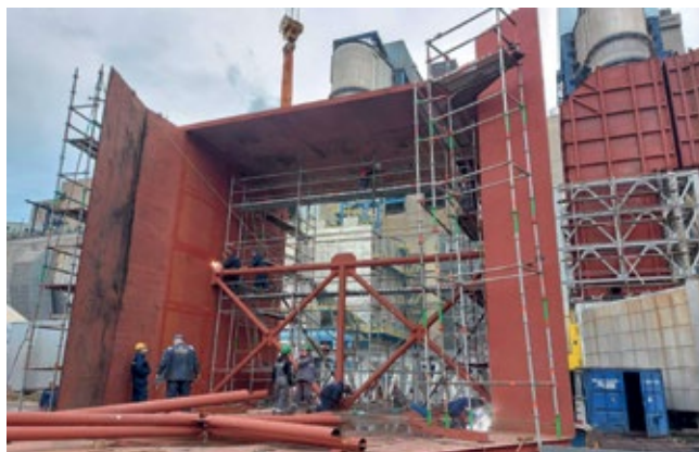
■ Канал димног гаса блока А4
