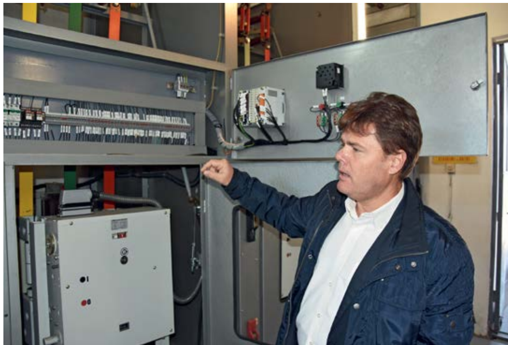
■ Орман релејне заштите и секундарне опреме на нивоу 10 kV хелије
