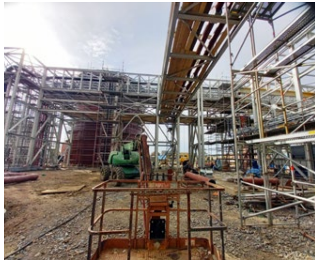
■ Монтажа цевног моста 6
