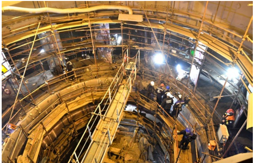
■ Санација металних делова у проточном тракту турбине
