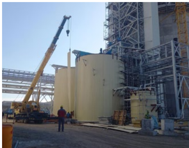
■ Монтажа лимене опшивке резервоара
