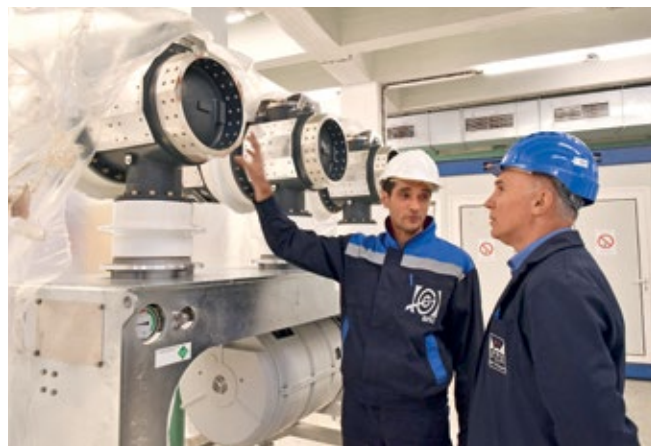
У овом ремонту А6 ће добити нови генераторски прекидач. Бобан Крчобић и Радован Миковић
