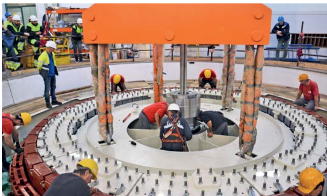
■ Монтажа ротора на генераторско вратило
