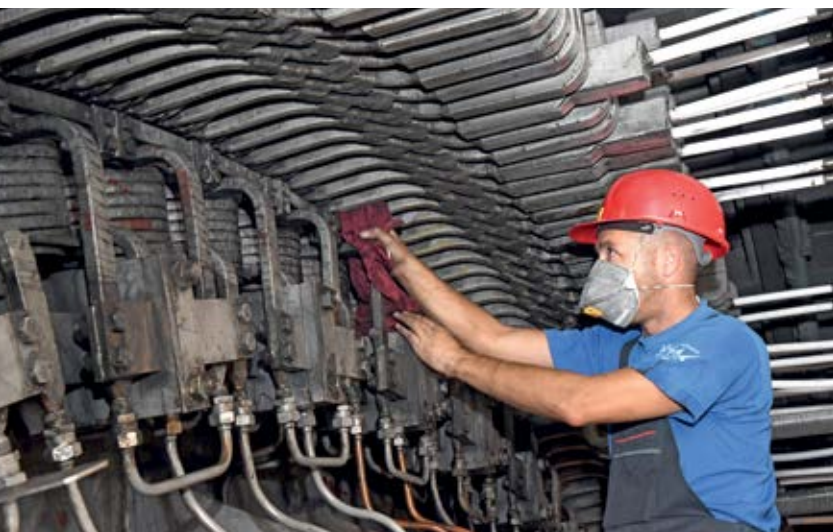
■ Генератор А1, чишћење графитне прашине, Мирослав Максимовић, електричар
