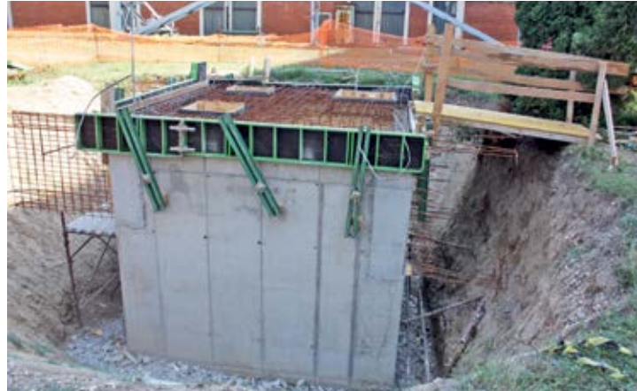
■ Црпна станица зауљених вода
