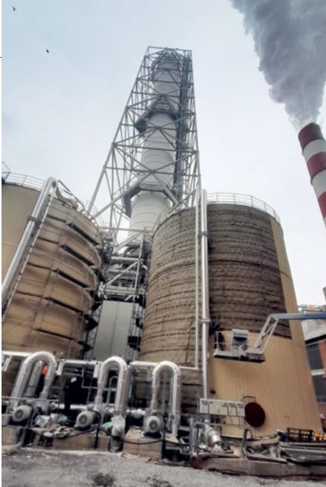
■ Резервоари процесне воде - монтажа лимене опшивке
