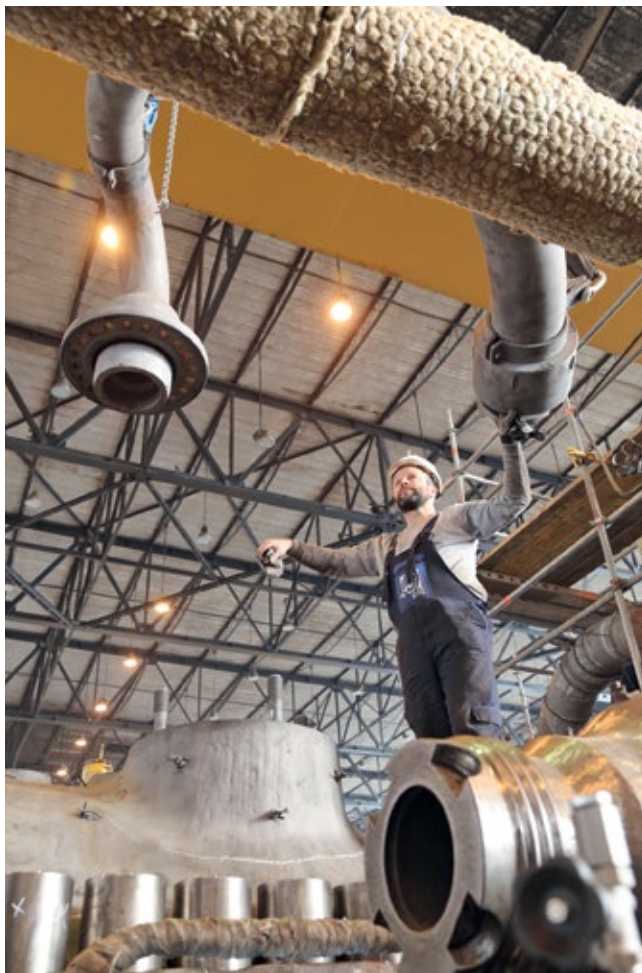
■ Радови на турбини високог притиска
