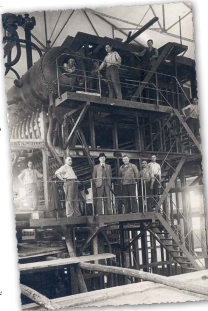
■ Монтажа котла из 1938. године
