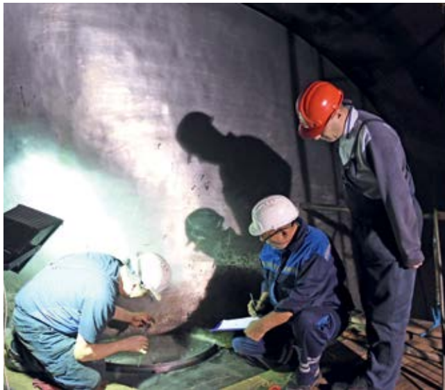
■ ХЕ „Ђердап 2“, ремонтна сезона траје пола године
