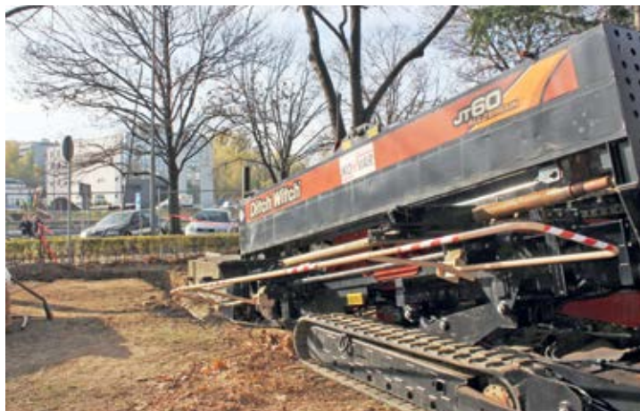
■ Специјална машина је пробијала земљу испод аутопута
