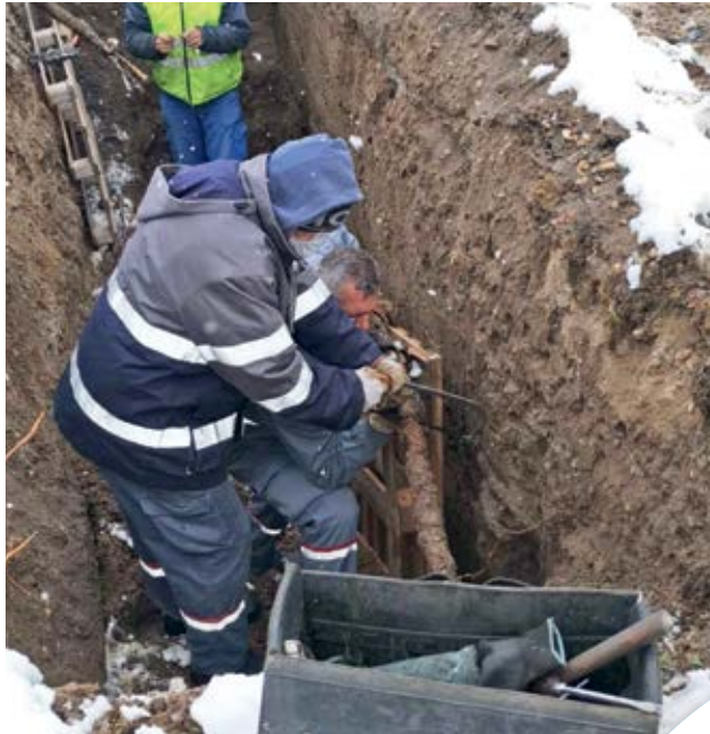
■ Алтина - интервенција на 10 kV подземном воду
