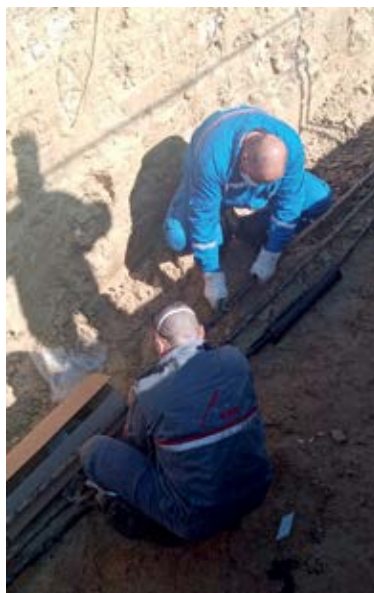
■ Депонија Винча, поправка 10 kV квара због радова друге фирме на топоводу
