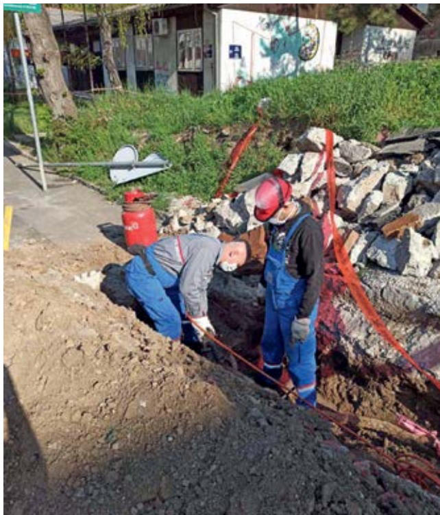
■ Сазонова улица, поправка подземног 10 kV кабла
