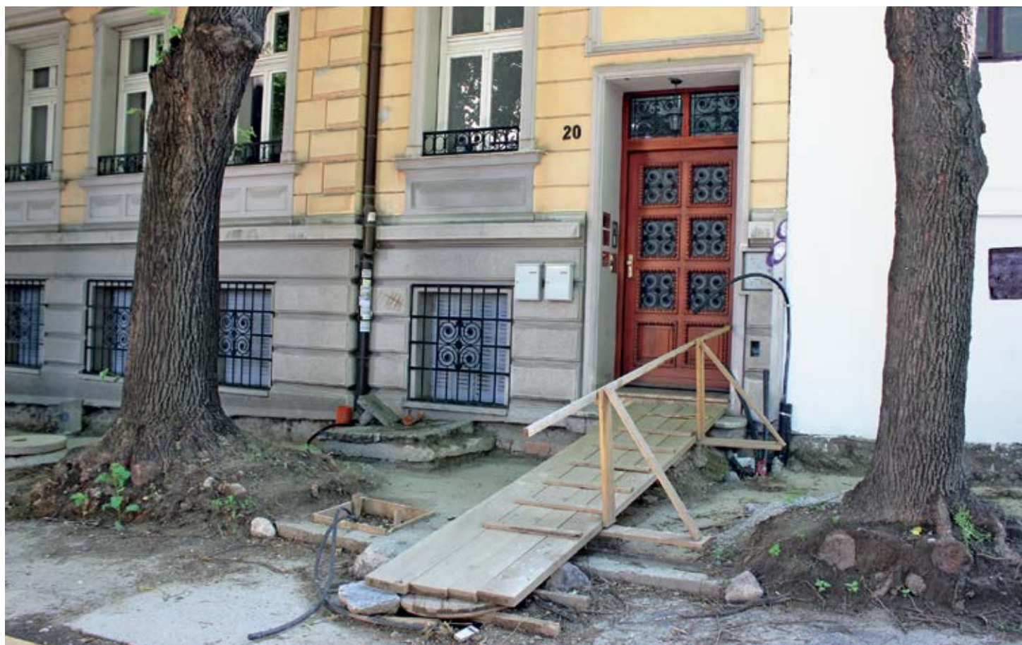
■ Реконструкција мреже на Косанчићевом венцу – надземни водови су демонтрани и положена је кабловска мрежа
