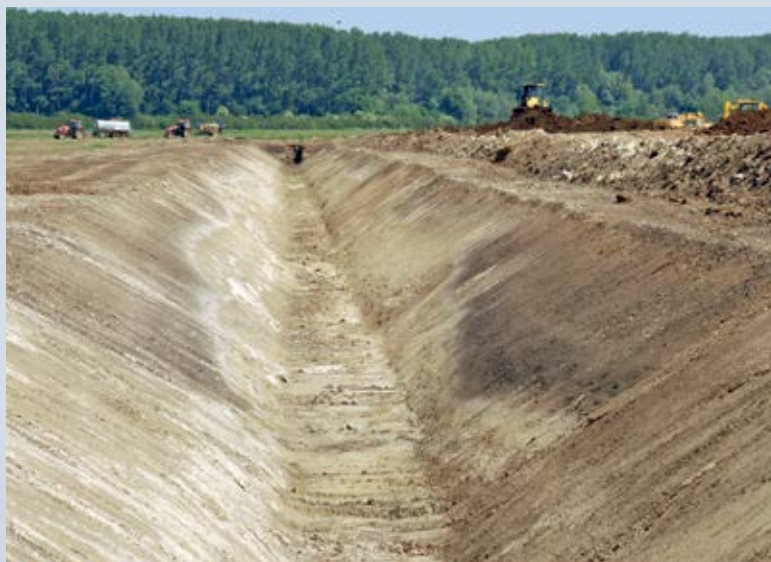
■ Изградња новог канала за прикупљање вода
