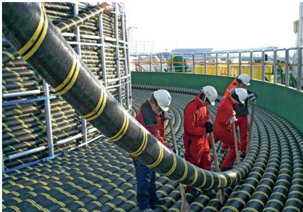
■ Високотисна кабл испод мора повезаће острва Сахалин и Хокаидо
