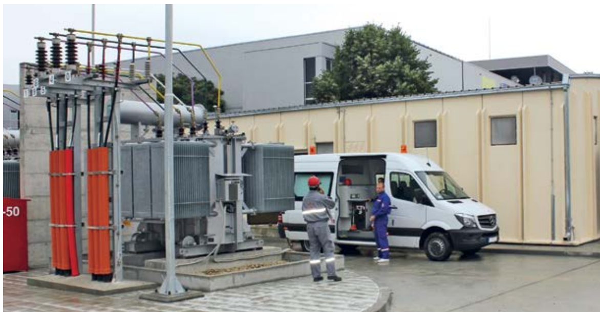
■ За потребе уклапања ТС 35/10 kV „Галеника“ у 10 kV мрежу, положено је 2.700 метара подземног електроенергетског кабла
