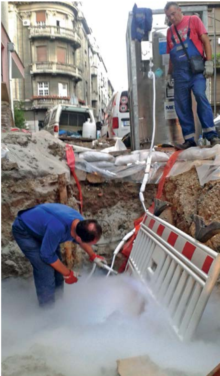
■ Замрзавање кабла течним азотом
