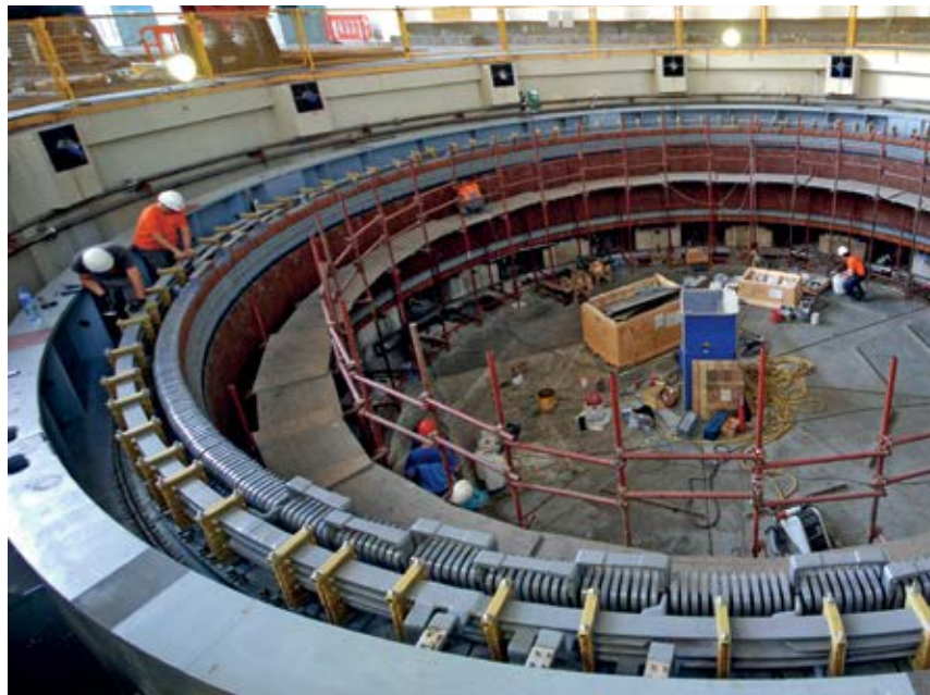
■ Статор генератора у завршној фази
