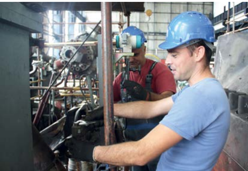
■ Радови на арматури у машинској хали
