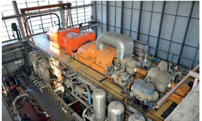
Ремонтна сезона у ТЕНТ-у започела је капиталним ремонтом блока ТЕ „Морава“
