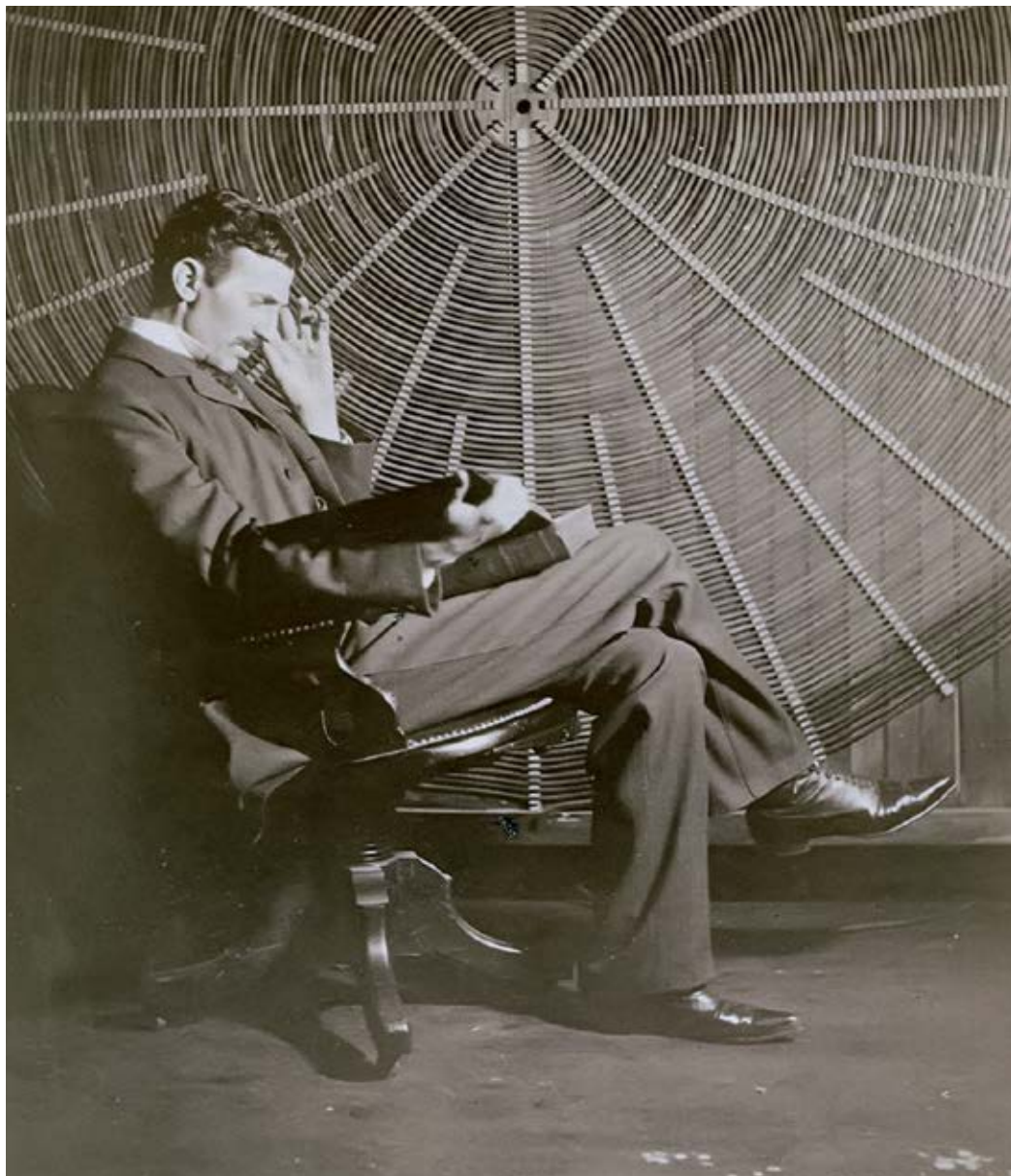
Никола Тесла испред спиралног секундара високофреквентног трансформатора
