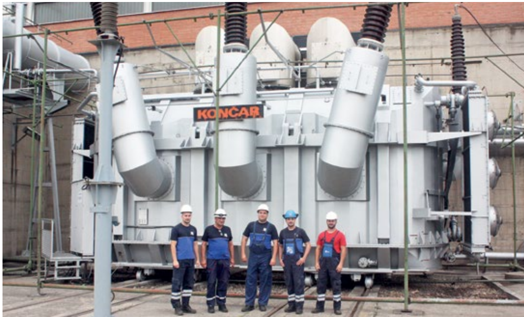
■ Део екипе ТЕНТ-а која је радила на ремонту трансформатора
