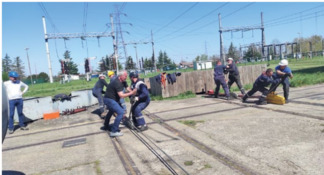
■ Ручно извлачење трансформатора
