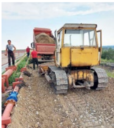
■ Насипање завршног слоја на касети 1
