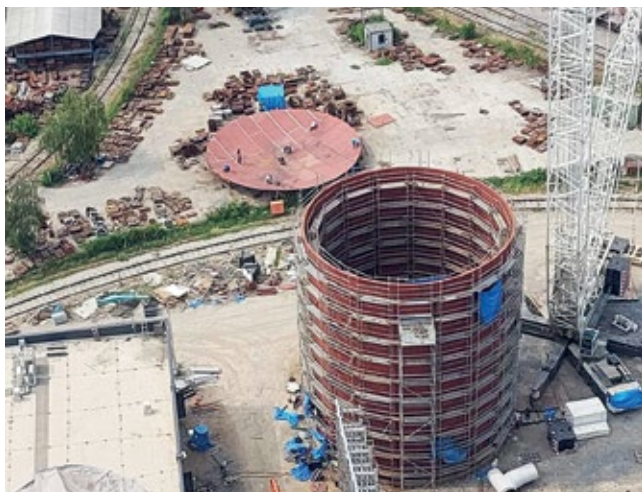
■ Ц8 резервоар - заваривање на резервоару
