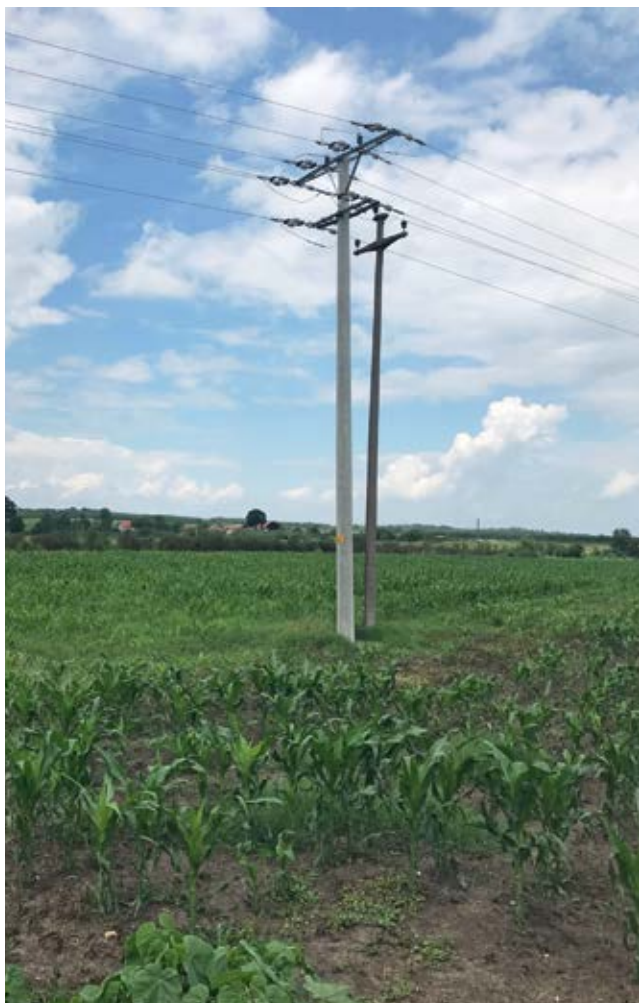
■ Реконструкцији ДВ 10 kV „Косанчић“ у пословници погона Бојник
