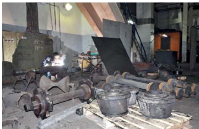
■ Ремонт блока А1
