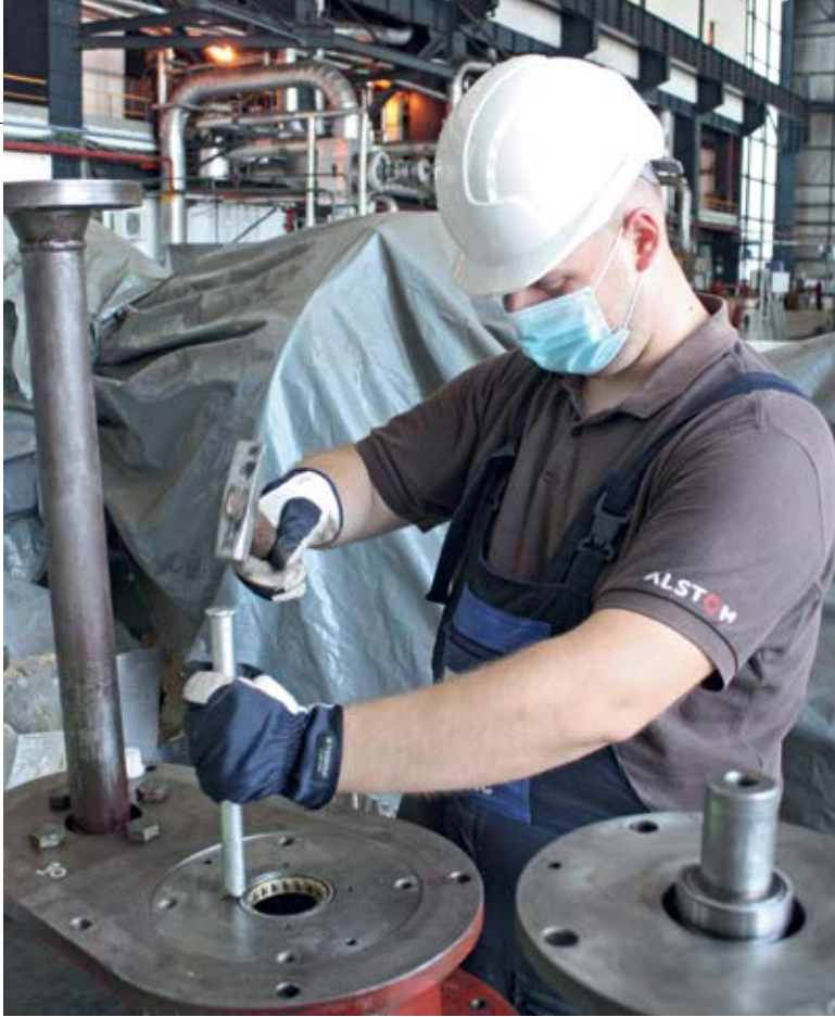
■ Радови на ремонту лежаја генератора ТЕНТ Б2
